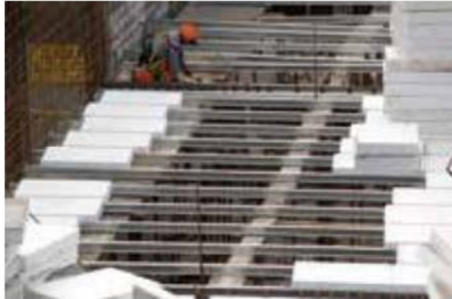
Figura 8: Colocación de casetones en el sistema de losa aligerada vigacero
