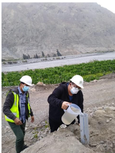
Figura 68. Llenar el tubo con agua para el ensayo de permeabilidad
