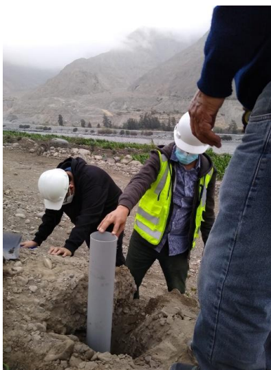
Figura 67. Colocación del tubo para el ensayo de permeabilidad
