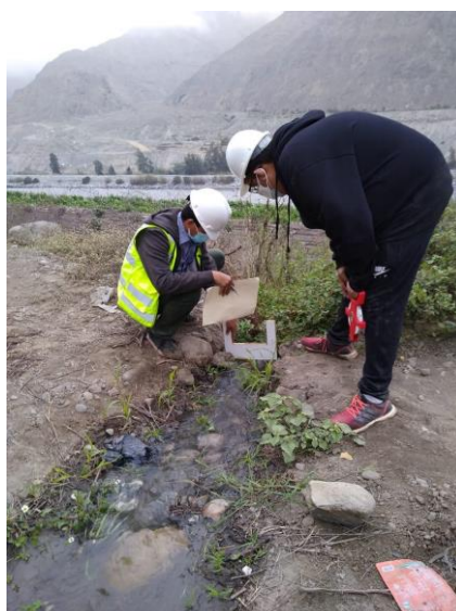
Figura 73. Colocación del vertedero
