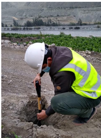
Figura 66. Excavación para el ensayo de permeabilidad
