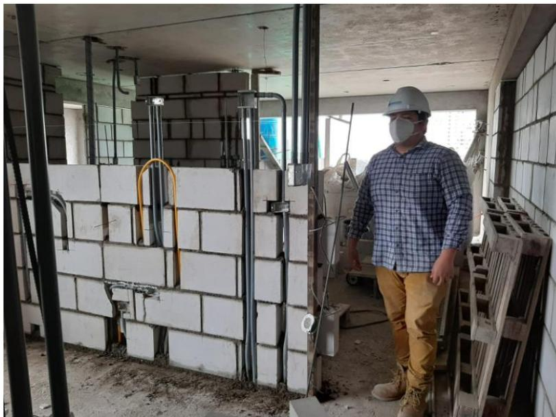
Figura N°32: Levantamiento de muros con ladrillo sílico calcáreo
