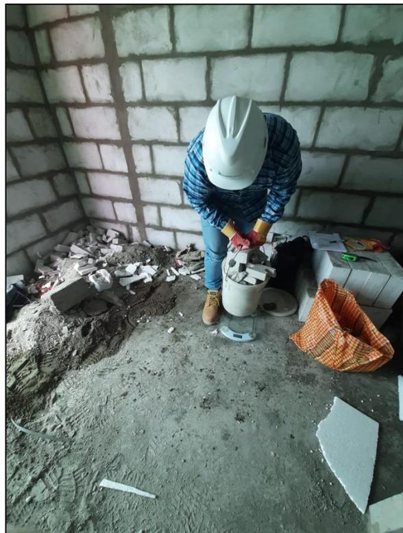
Figura N°62:Pesaje de los residuos generados en el piso N°7
