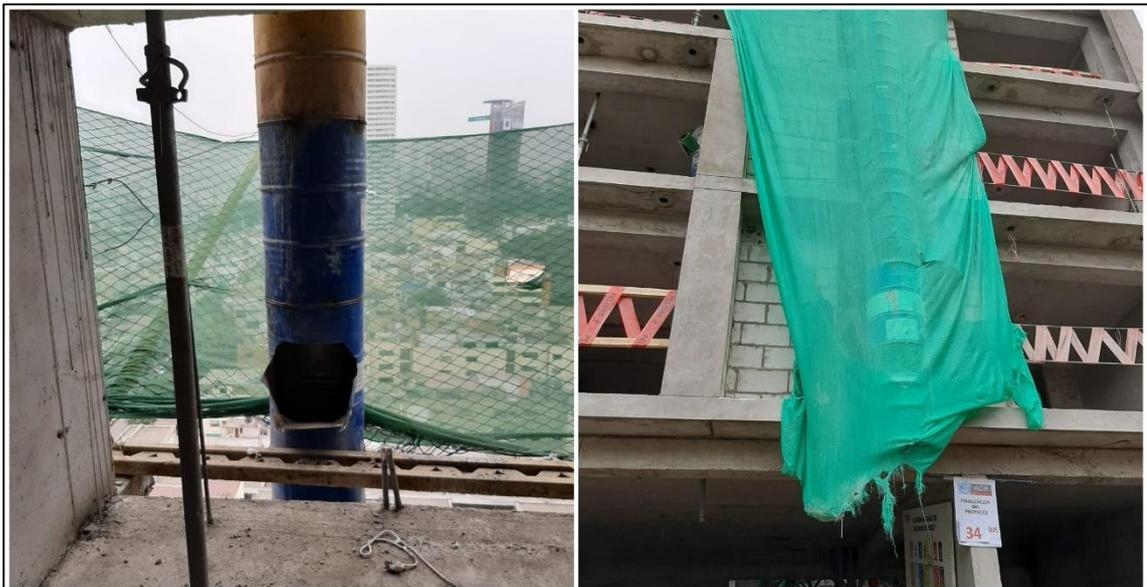
Figura N°28: Chute para el traslado de los residuos de construcción desde cada piso.
