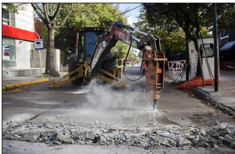
Figura N°18:Renovación de asfalto en una calle en el distrito de San Isidro
