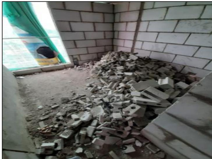
Figura N°64: Área de depósito de los residuos de construcción y demolición en el piso 12
