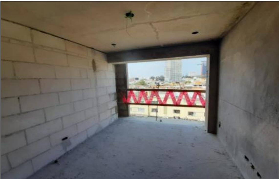
Figura N°36: Casco gris culminado en los pisos inferiores
