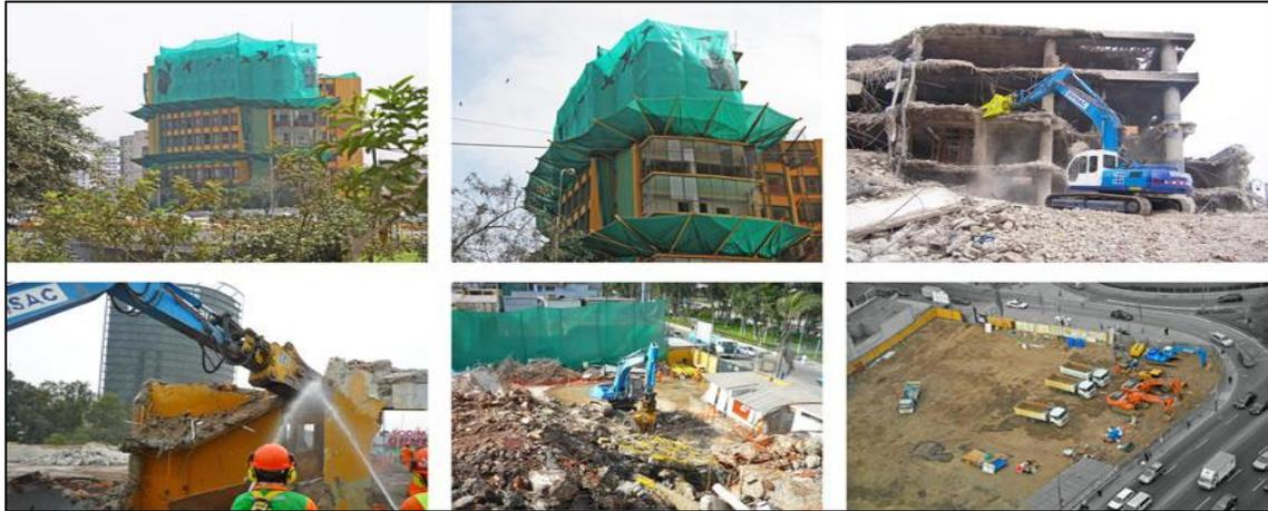
Figura N°15: Residuos de demolición del proyecto de las Torres de Limatambo
