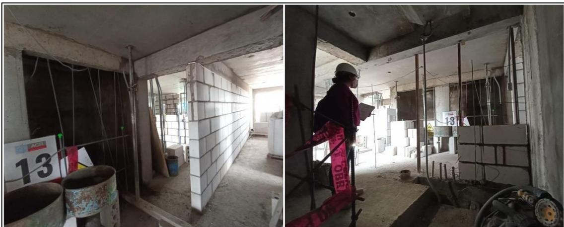
Figura N°34: Piso N° 13 y Piso N° 14 levantamientos de muros de albañilería.
