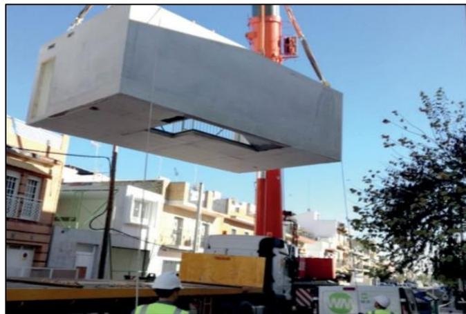
Figura N°16: Instalación de vivienda industrializada de hormigón
