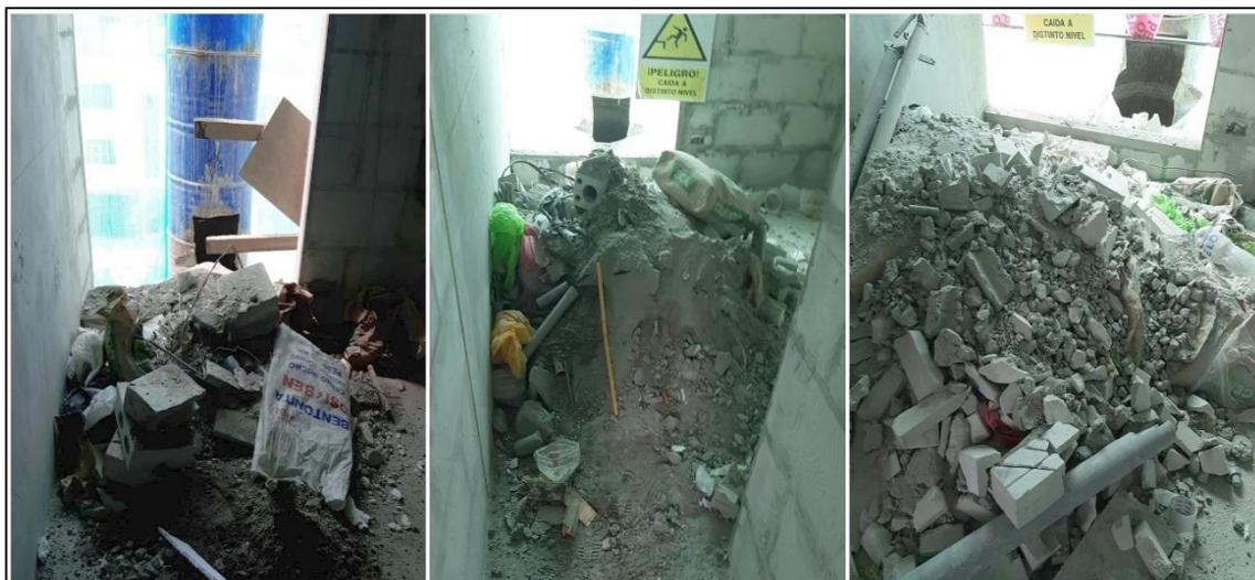
Figura N°55: Área de depósito de los residuos de construcción y demolición de los pisos 5, 6 y 8
