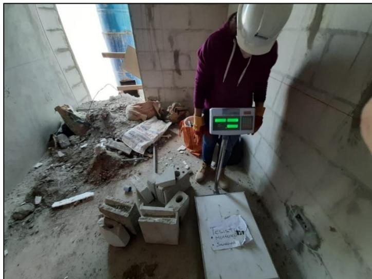
Figura N°58: Pesaje de los residuos generados en el piso N°5
