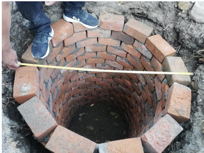
Figura N° 21: Pozo excavado con el muro de ladrillo construido
