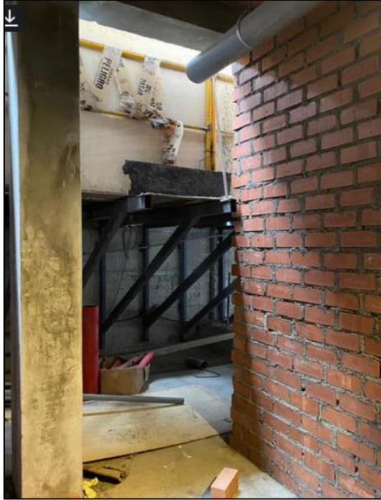
Figura 16. Incompatibilidad con la tubería de desagüe y muro de drywall.
