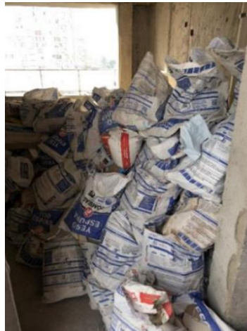
Figura 35 Uso de sacos para acarreo y acopio de escombros.
