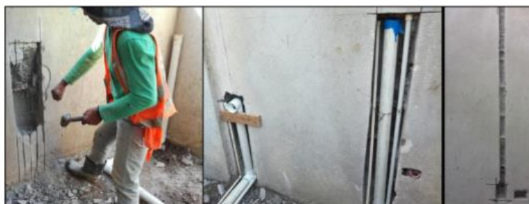
Figura 24 Picado de muros para colocación de tuberías
