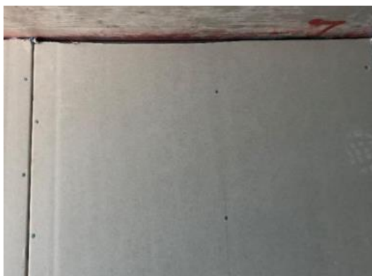
Figura 30 Tabique cortado para ajuste a altura de piso
