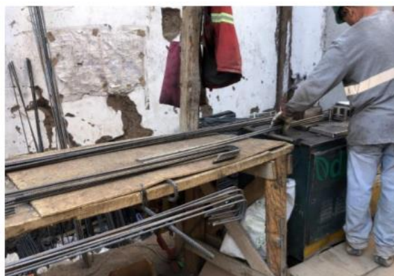
Figura 28 Trabajador doblando barras de refuerzo en taller de habilitación del acero.
