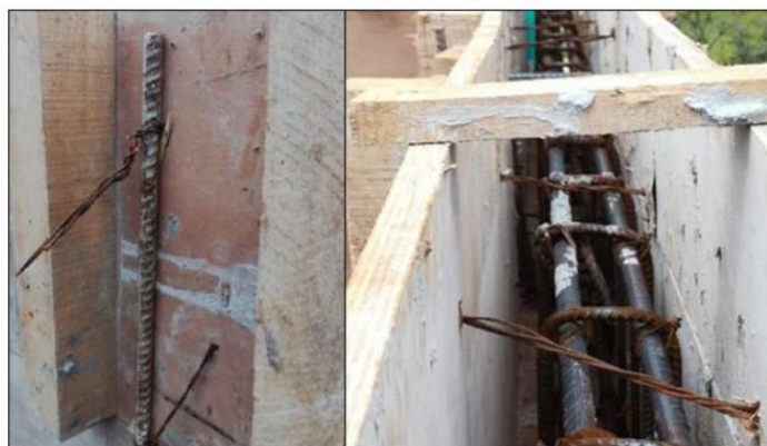
Figura 23 Colocación de acero y encofrado
