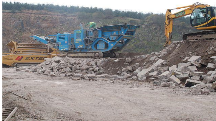
Figura 38 Triturado de residuos de Demolición
