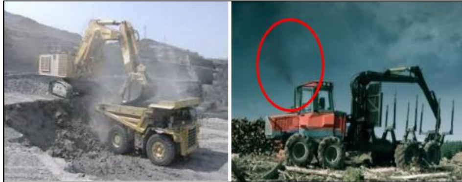
Figura 18 Generación de emisiones atmosféricas por el uso de máquinas de construcción
