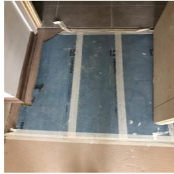
Figura 31 Cartón como protección de pisos terminados.
