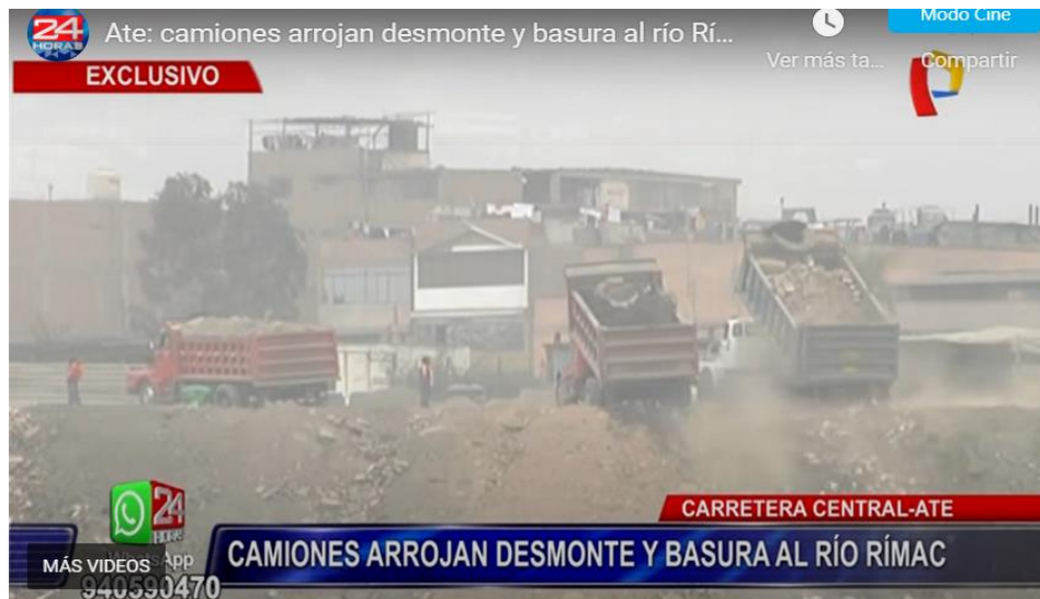
Figura 8 Arrojan residuos en el cauce del río Rímac
