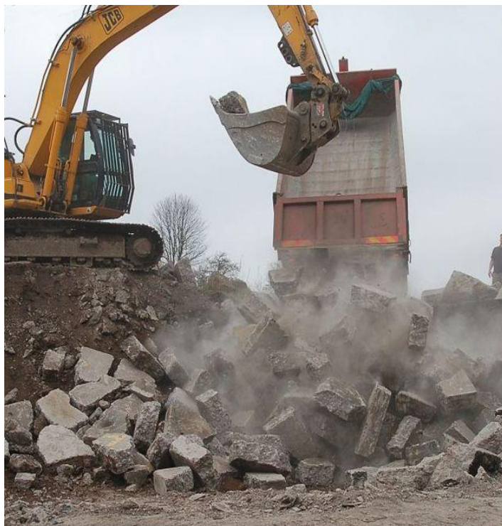
Figura 37 Acopio de residuos de Demolición y Selección de Residuos
