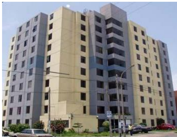
Figura N° 3: Edificio con Muros de ductilidad limitada
