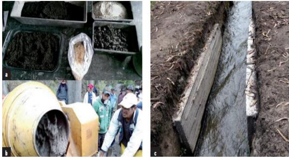
Figura N° 15: Aplicación de bioconcreto en canales de regadío.
