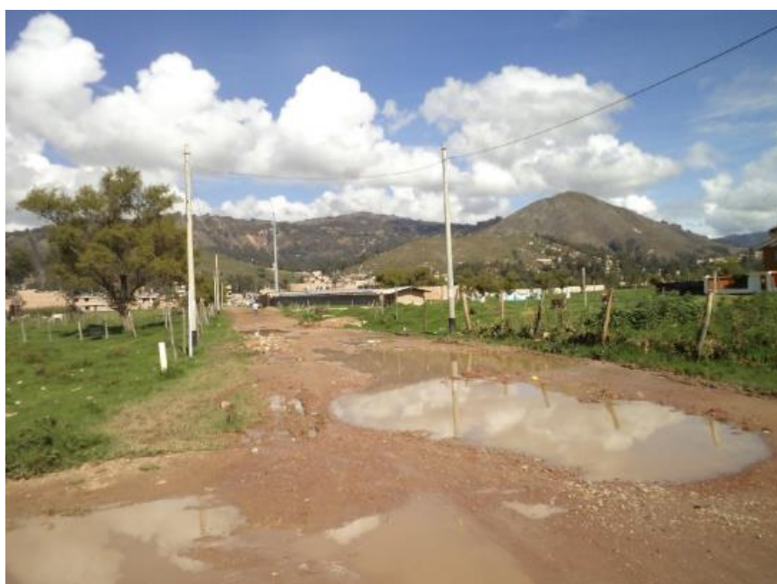
Figura 2: Carretera No Pavimentada de Bajo Volumen de Tránsito
