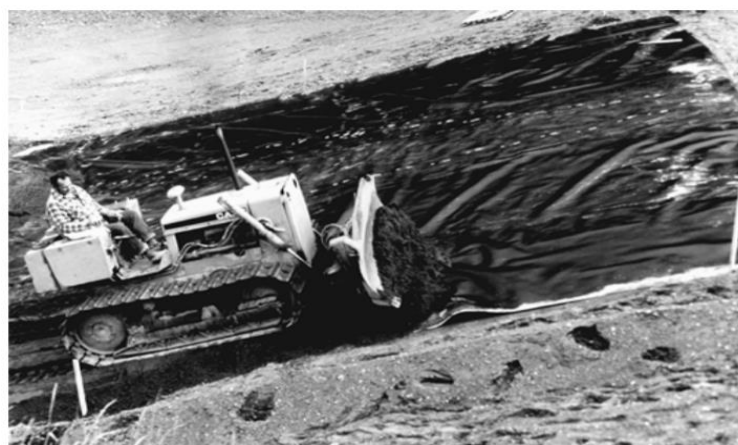
Figura 6: Esparcimiento de suelo cemento sobre carretera en pendiente
