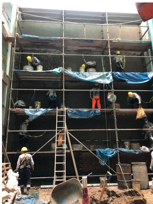
Figura 41. Operario en tarrajeo de muros interiores Operarios instalándose en su respectivo, después de armar el andamio.
