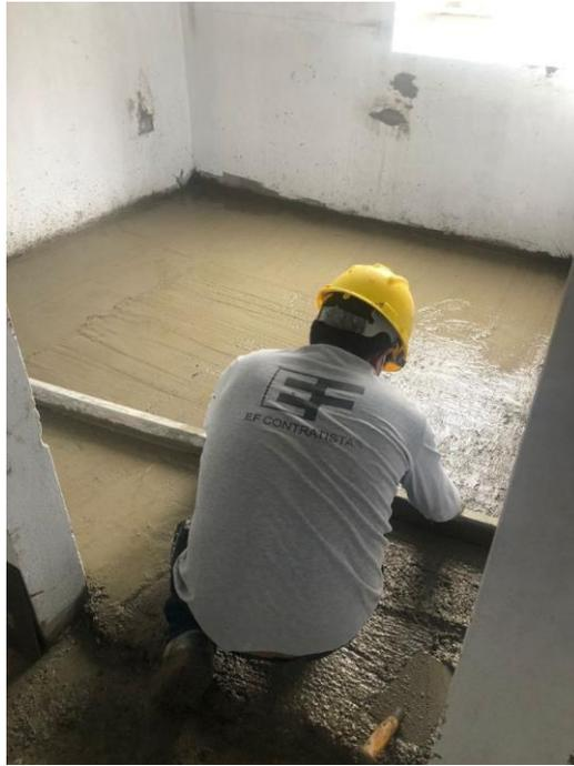
Figura 34. Regleado y pulido de la superficie de contrapiso.
