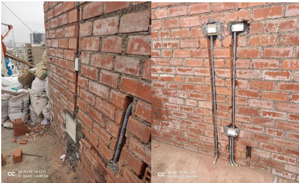
Figura 49. Instalación de interruptores y cajas de paso.
