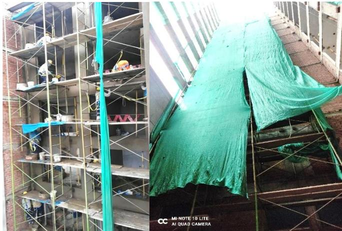
Figura 39. Tarrajeo de muros interiores, zona de tragaluz.
