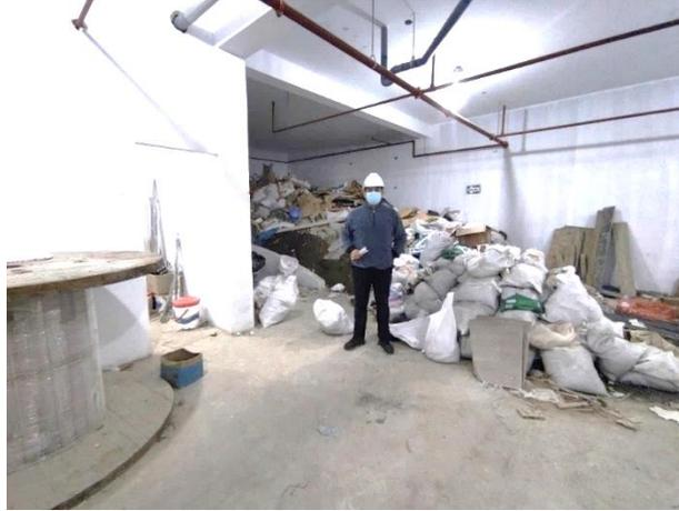
Figura 10. Sótano uno, zona de almacén de RCD, en este punto de la obra se acumulaba los RCD que provienen de la acumulación de cada piso.
