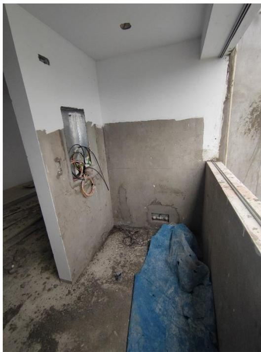
Figura 47. Colocación de tablero de distribución.
