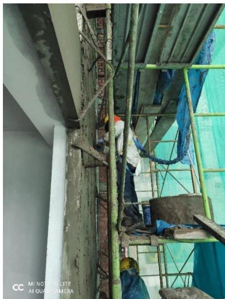
Figura 40. Operario en tarrajeo de muros interiores.
