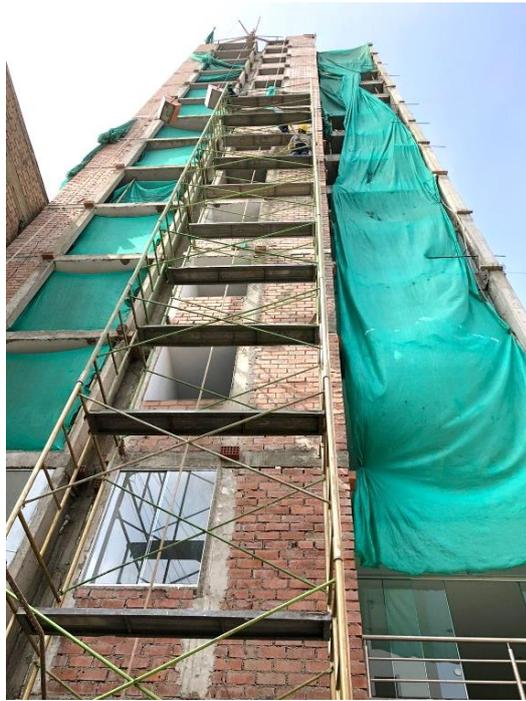
Figura 35. Armado de andamios para realizar el tarrajeo.
