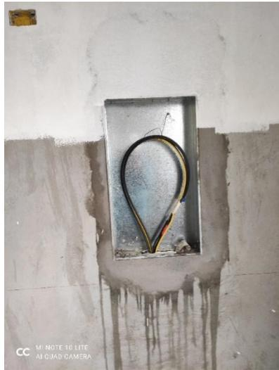
Figura 46. Colocación de tablero de distribución
