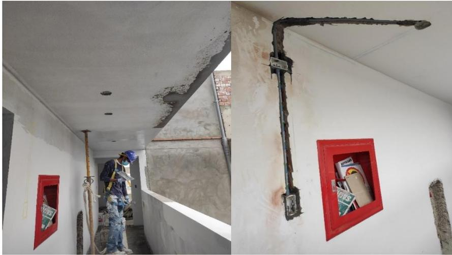
Figura 48. Picado o demolición para instalaciones eléctricas..
