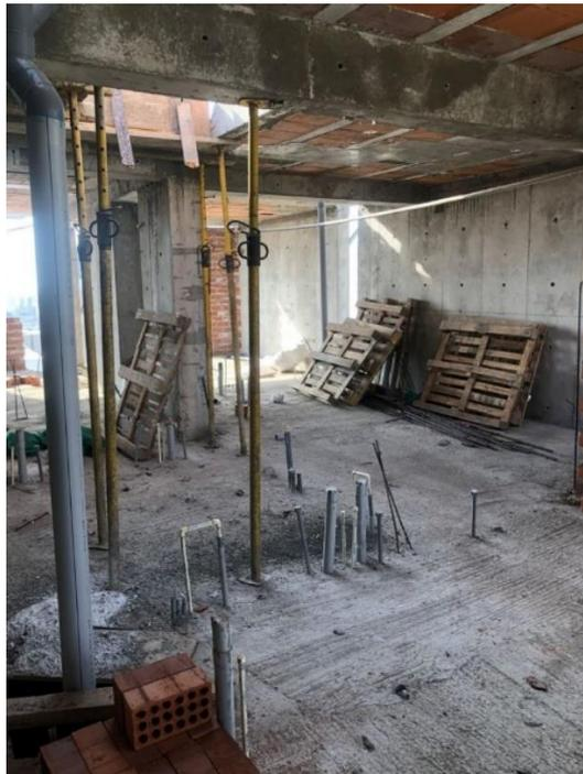
Figura 31. Superficie donde se va desarrollar vaciado, antes de la limpieza.
