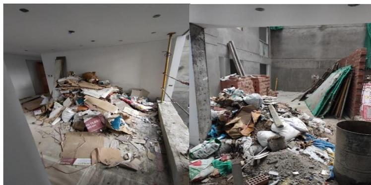
Figura 12. Primera de la edificación, en este plante con ayuda del winche, se baja los residuos por cada piso.
