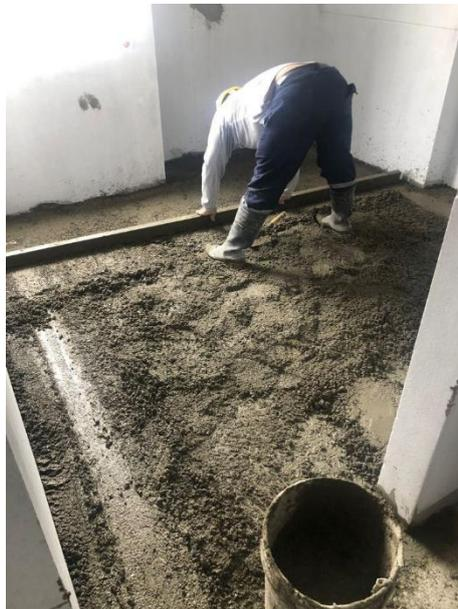
Figura 33. Regleado del concreto vaciado.
