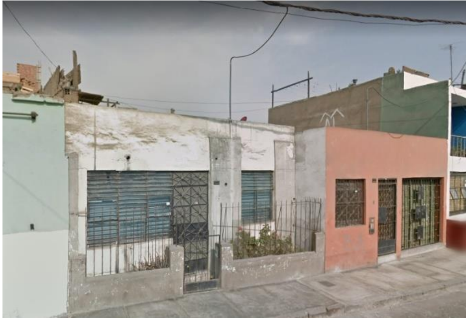
Figura 16: Edificación de albañilería de un piso en Barrios Altos. Fuente: Google Maps, 2014.
