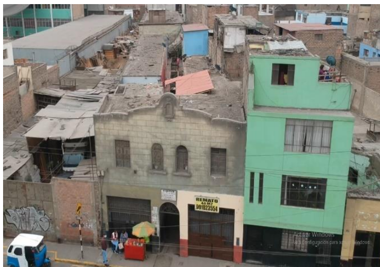
Figura 10: Vista frontal de viviendas dentro del área de estudio, Barrios Altos. Fuente: Elaboración propia.
