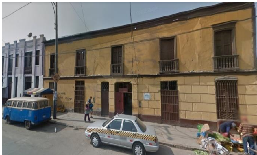
Figura 15: Edificación de adobe de dos pisos en Barrios Altos. Fuente: Google Maps, 2014.
