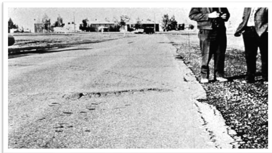
Figura N°18: Severidad medio en abultamientos (M) Fuente: American Society for Testing and Materials, 2018
