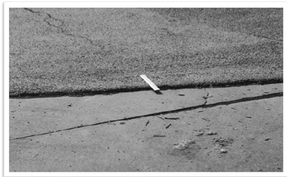
Figura N°49: Desplazamiento de Severidad Media (M)
