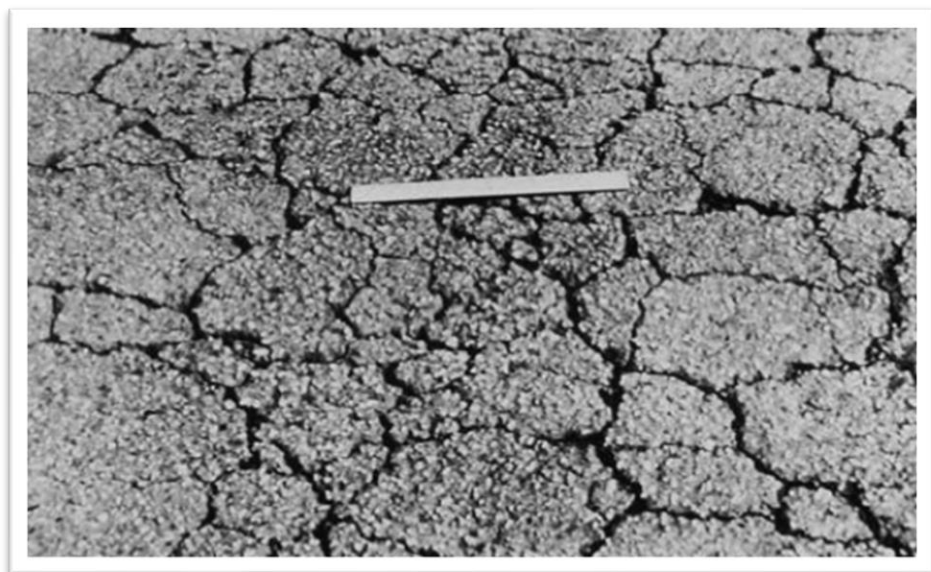
Figura N°10: Severidad Alta de Piel de Cocodrilo (H) Fuente: American Society for Testing and Materials, 2018
