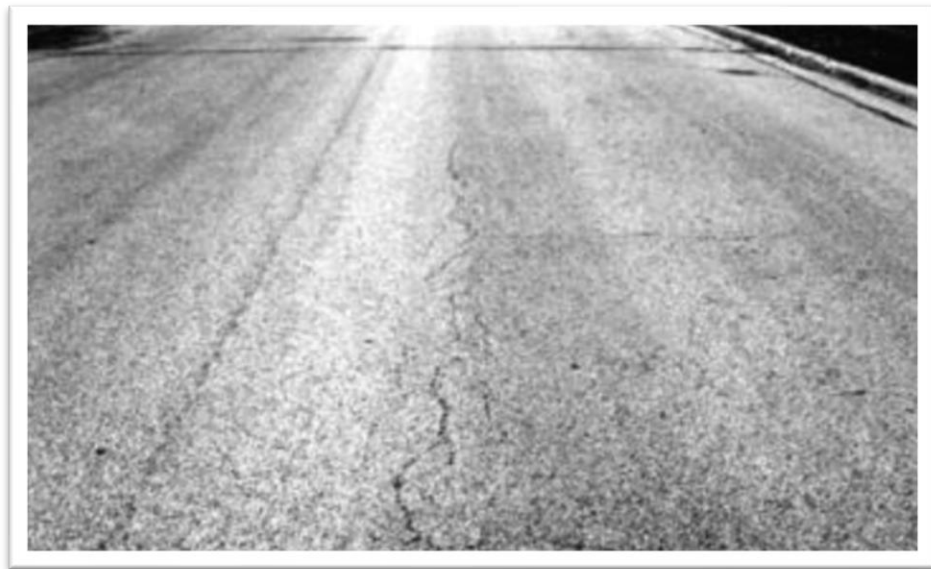
Figura N°8: Nivel de severidad Piel de Cocodrilo (L) Fuente: American Society for Testing and Materials, 2018
