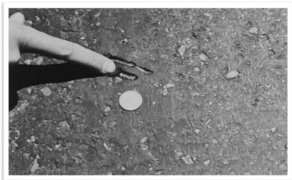
Figura N°12: Severidad medio de exudación (M) Fuente: American Society for Testing and Materials, 2018
