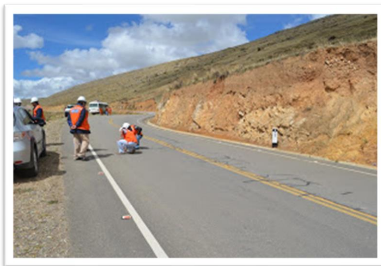
Figura N°4: Sellado de Grietas con asfalto Fuente: Sellado de Fisuras en Asfaltos y Pavimentos en Perú.
