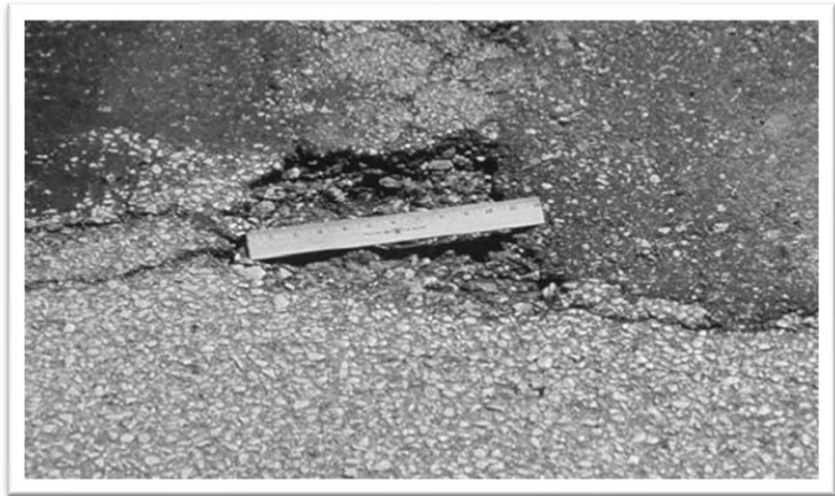
Figura N°42: Parches de Severidad Baja (L). Fuente: American Society for Testing and Materials, 2018
