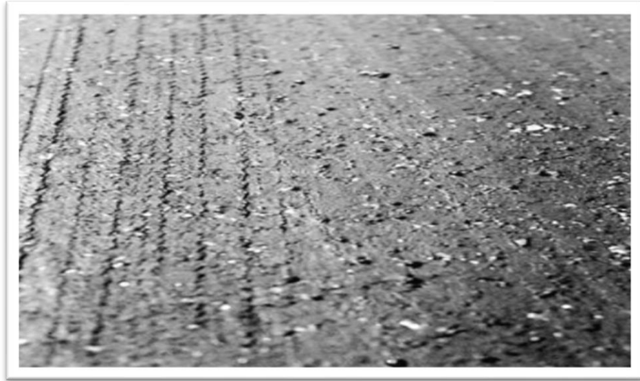
Figura N°13: Severidad Alta de Exudación (H) Fuente: American Society for Testing and Materials, 2018
