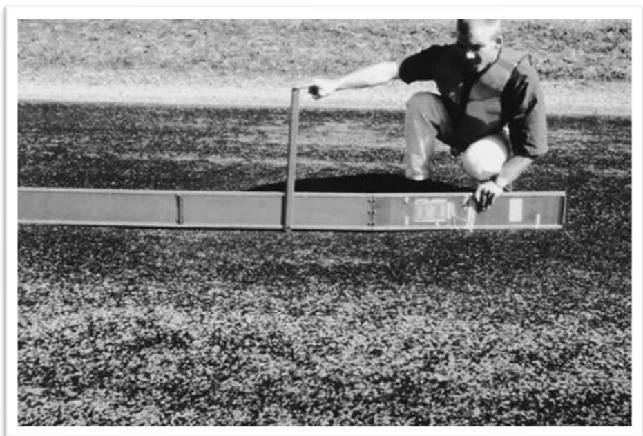
Figura N°23: Depresión con Severidad baja (L) Fuente: American Society for Testing and Materials, 2018
