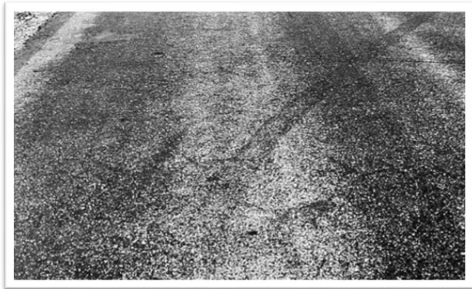
Figura N°11: Bajo nivel de severidad de exudación (L) Fuente: American Society for Testing and Materials, 2018
