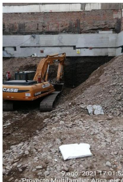
Figura 21: Excavación de banquetas
