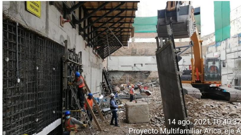
Figura 25: Encofrado de muro pantalla
