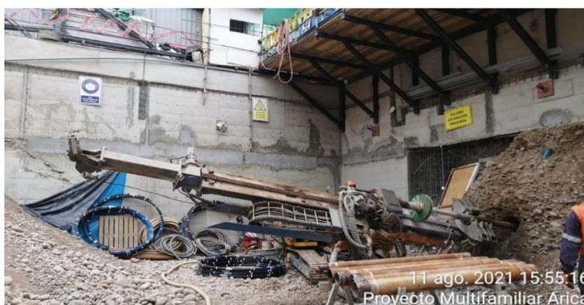
Figura 22: Anclajes postensados
