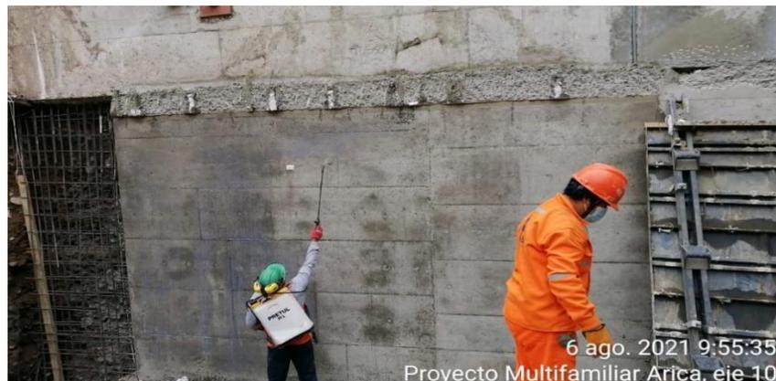
Figura 27: Desencofrado y curado químico de muros
