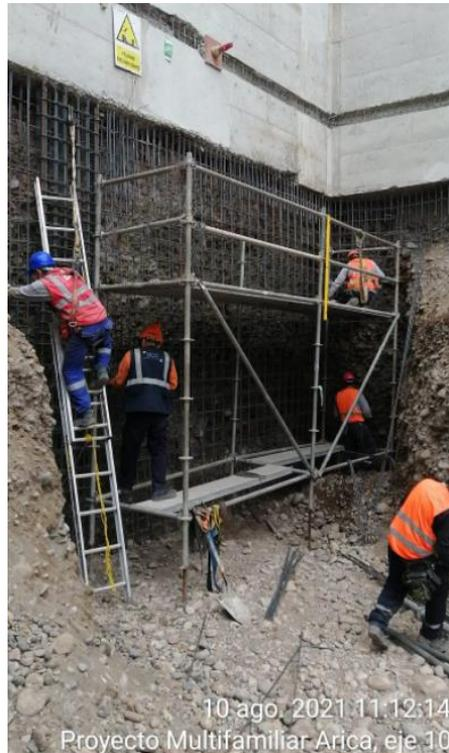
Figura 24: Muro pantalla anclados
