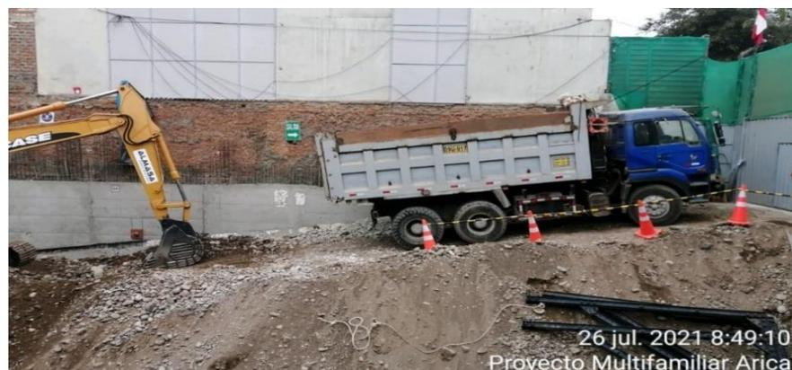
Figura 20: Eliminación con rampa
