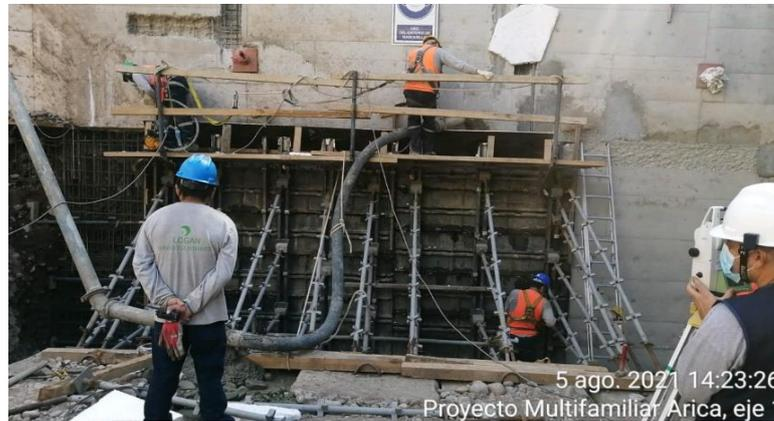
Figura 26: Vaciado en cada paño de muro anclado (a partir del 2° anillo)
