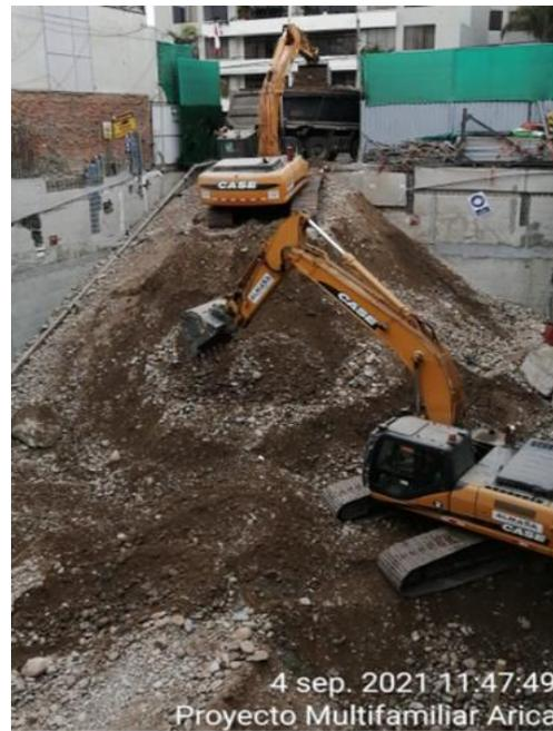
Figura 19: Excavación masiva
