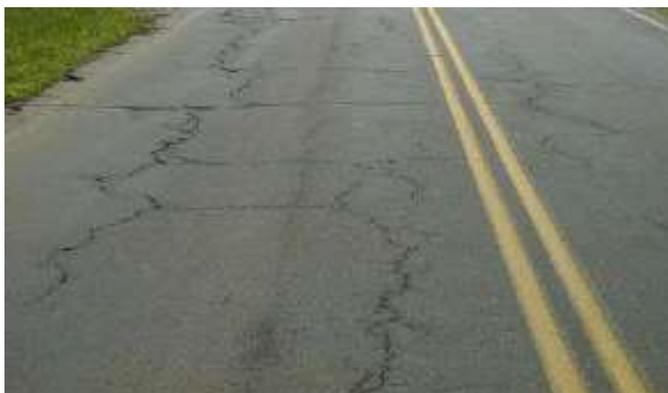
Figura 8: Fisuras en bloques
