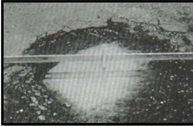
Figura 1.17. Hueco de alta severidad (L. Ricardo, 2002)
