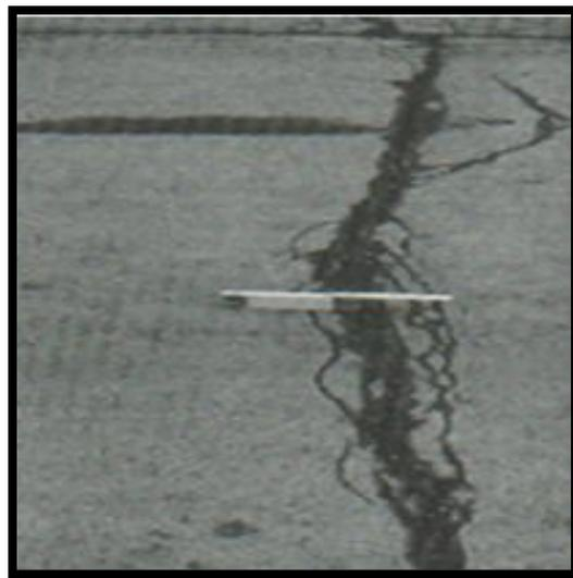
Figura 1.23. Grieta de reflexión de junta de alta severidad (L. Ricardo, 2002)
