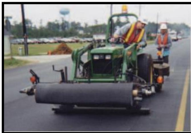
Figura 3.29. Colocación mecánica del sistema GlasGrid. (T.I.C., 2008)
