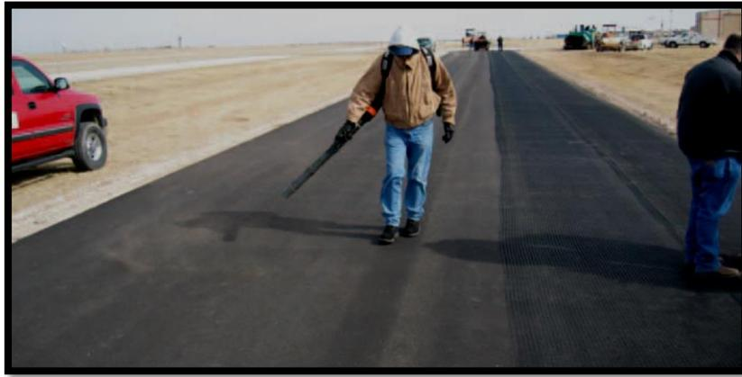
Figura 3.27. Limpieza de la superficie. (T.I.C., 2008)
