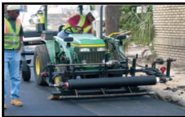
Figura 3.32. Traslape del sistema GlasGrid a través de la junta transversal o longitudinal. (T.I.C., 2008)
