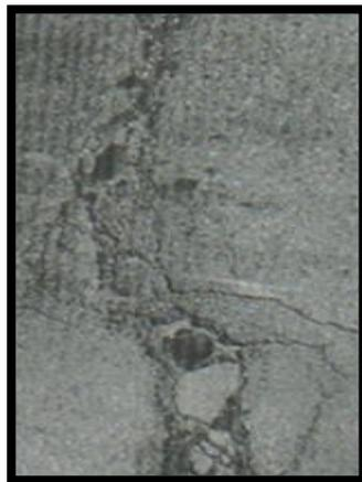
Figura 1.20. Grietas longitudinales y transversales (no PCC) de alta severidad (L. Ricardo, 2002)
