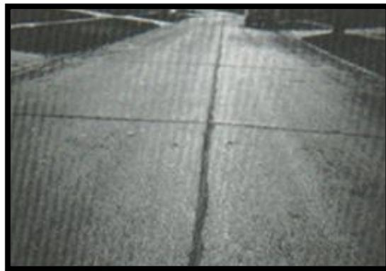
Figura 1.21. Grieta de reflexión de junta de baja severidad (L. Ricardo, 2002)
