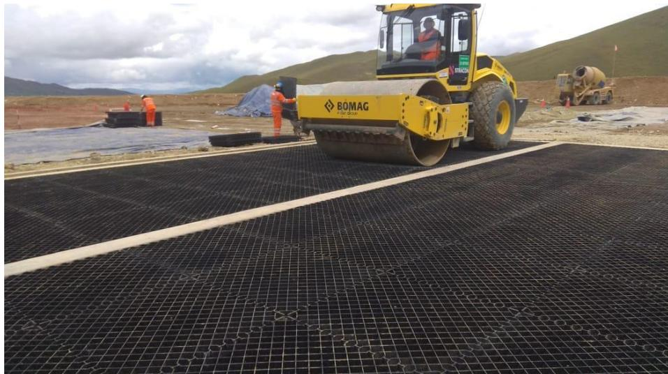
Figura 99. Compactado de Sistema Diamond Grid.
