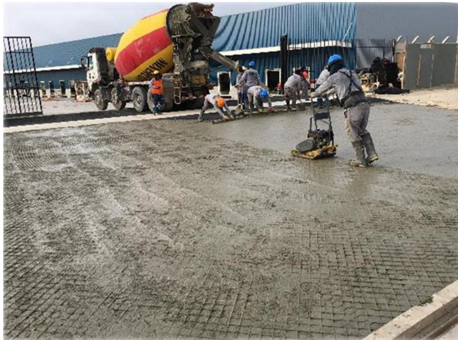
Figura 14. Planchado compactador del sistema concreto-Diamond Grid
