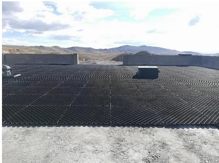
Figura 11. Colocación de la geomalla Diamond Grid.
