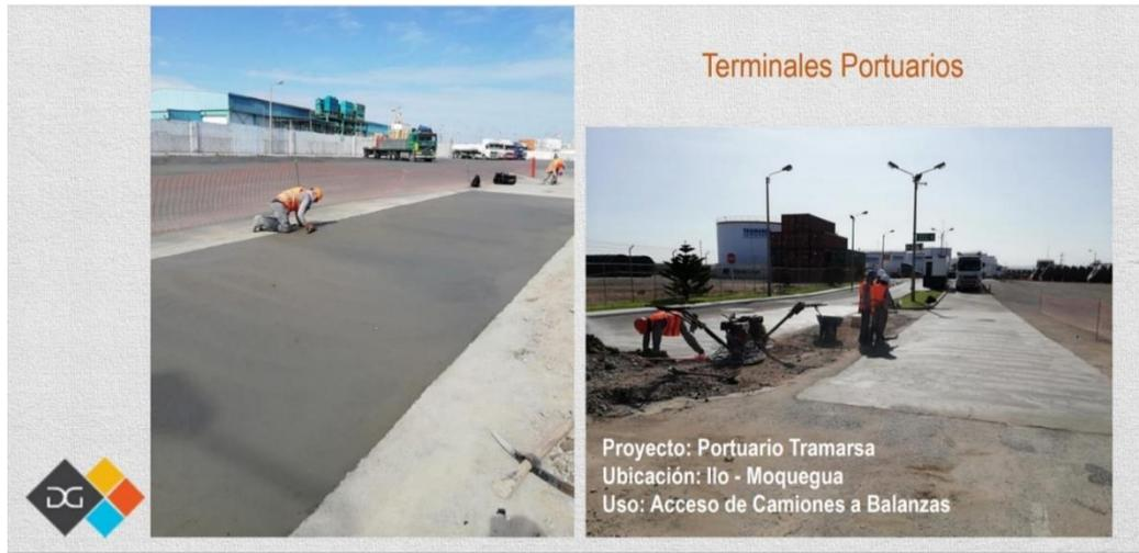
Figura 24. Vibrado de concreto
