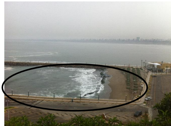
Figura 0.5. Playa N° 3 tras la colocación del geotubo – 2011. Fuente: Club Regatas Lima
