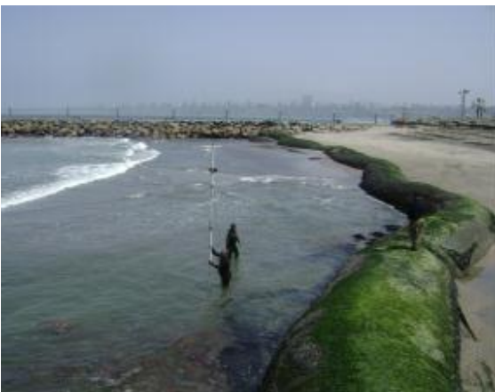
Figura 0.4. Batimetría con buzos (alrededor del geotubo).
