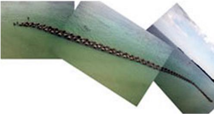
Figura 0.8. Dique exento con unidades prefabricadas.
