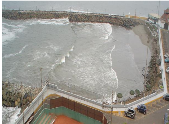
Figura 0.4. Playa N° 3 erosionada. Fuente: Club Regatas Lima.
