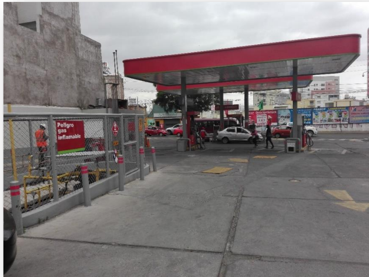
Figura 1 Panorámica de la Estación de Servicios
