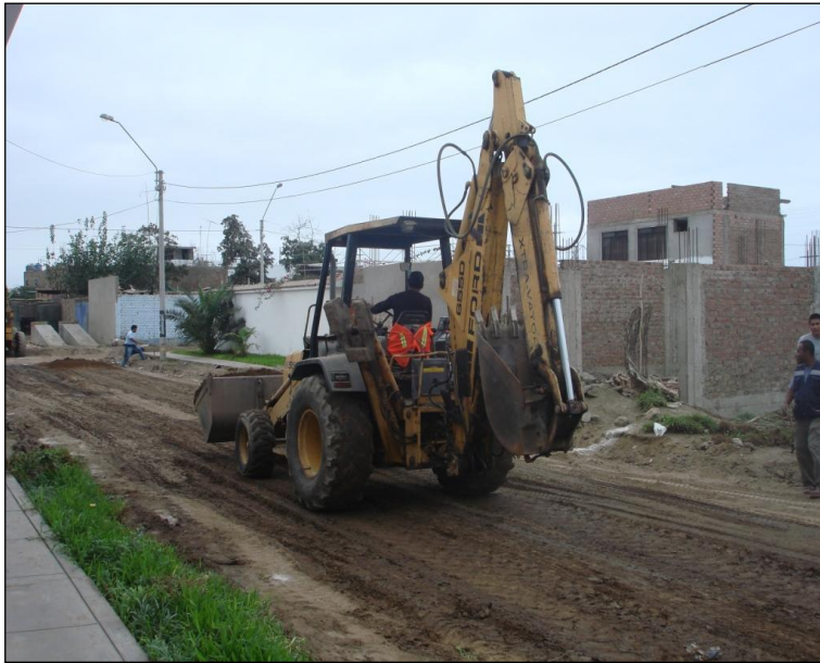
Imagen 26- Retroexcavadora transportando el material para el mejoramiento de la sub rasante
