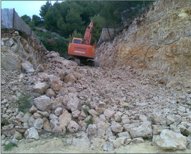
Imagen 12-Excavación para explanaciones en roca
