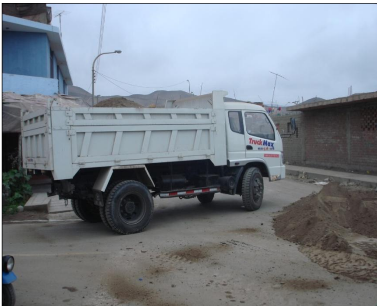
Imagen 23- Camión cargado con material de eliminación
