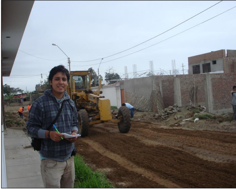
Imagen 17-Mejoramiento de la Sub-rasante
