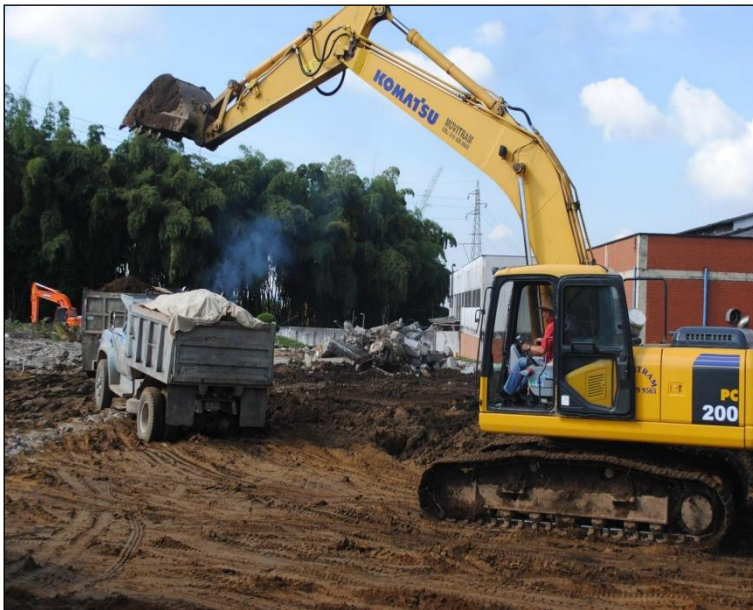
Imagen 10-Demolición y remoción
