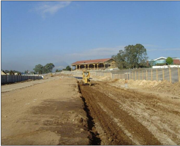
Imagen 13-Excavación en explanaciones en material común
