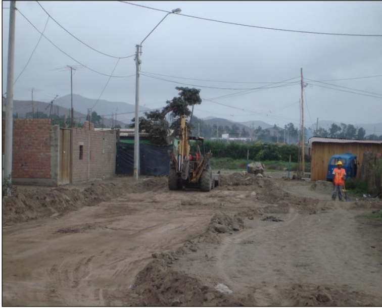
Imagen 21- Retroexcavadora acumulando el material de corte
