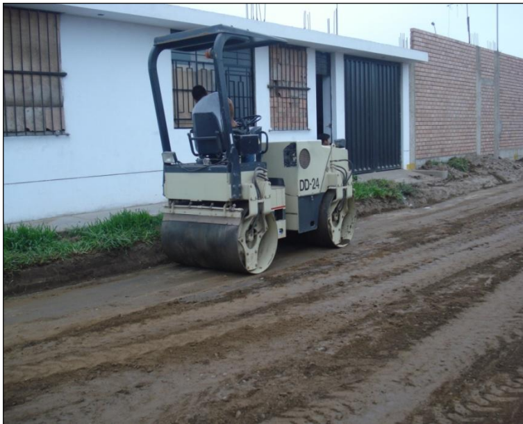
Imagen 29- Compactación del material mejorado
