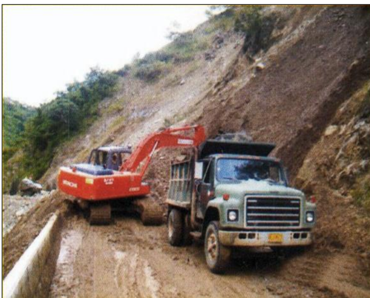
Imagen 14-Remoción de Derrumbes
