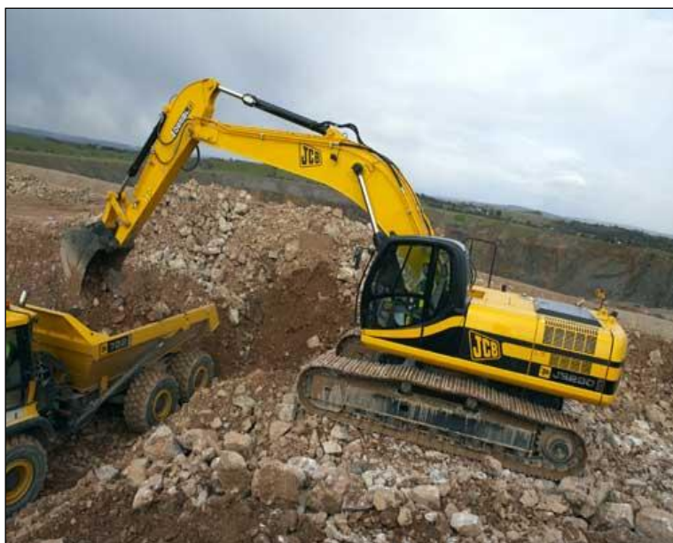
Imagen 11-Excavación en explanaciones sin clasificar
