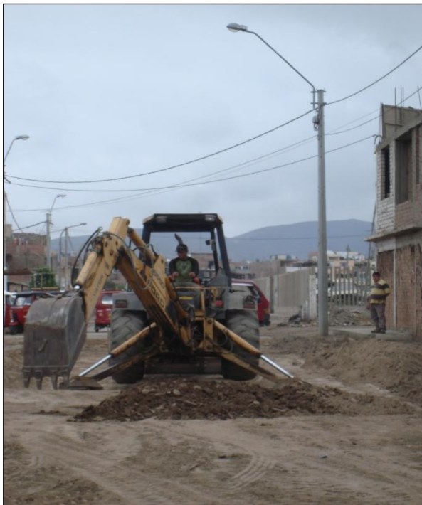
Imagen 20- Retroexcavadora haciendo cortes a nivel de la sub-rasante
