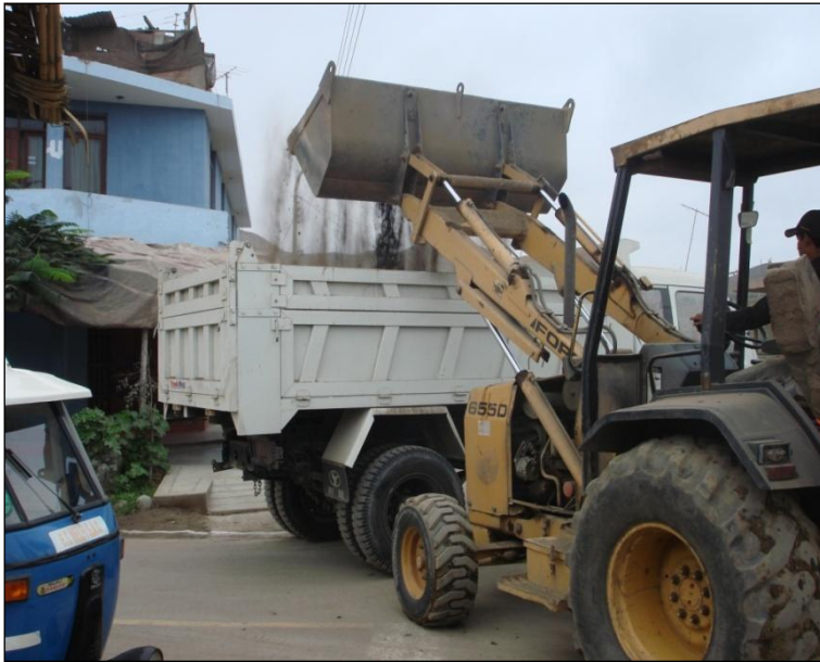
Imagen 22- Retroexcavadora eliminando el material de corte
