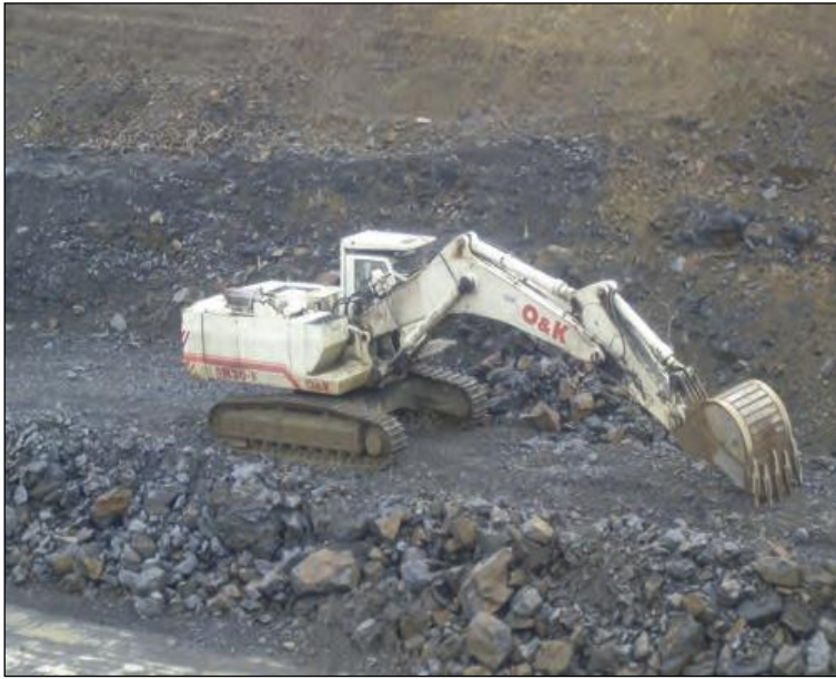
Imagen 16-Conformación del Pedraplén
