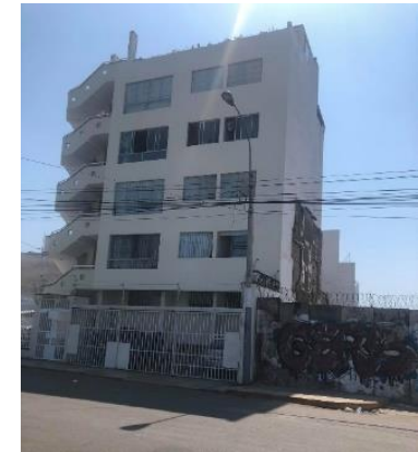
Imagen 39. Fotografía del estado de la fachada edificio multifamiliar
