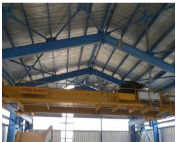
Puente Grúa en ECHS, Terminado y probado en vacío y carga
