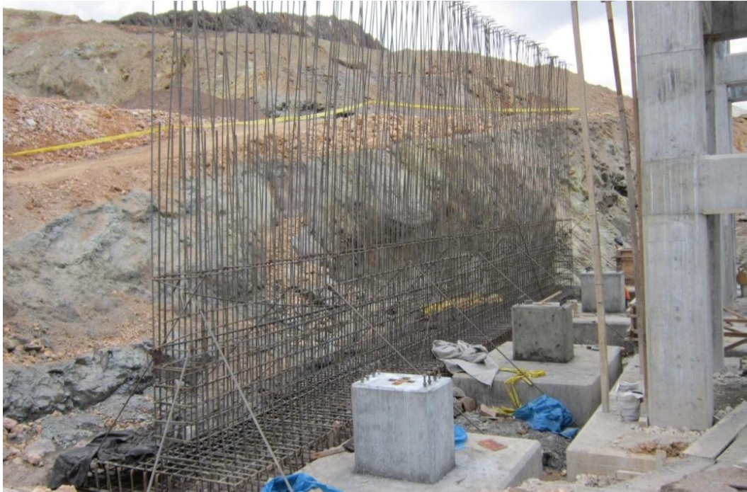
Imagen N°27: Vista de las dos (02) plataformas y el muro en mención.
