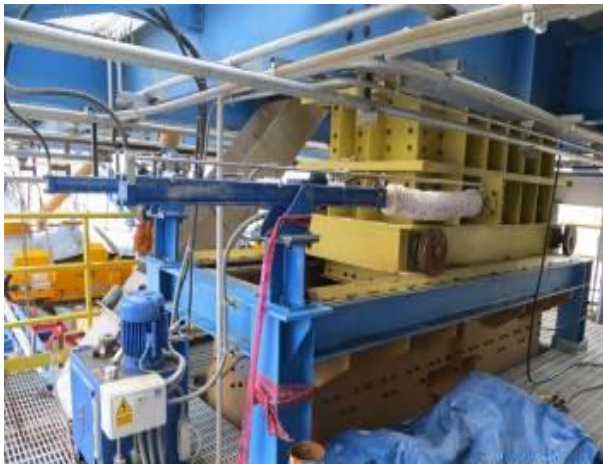
Pantalon de descarga a Faja CV-02 y CV-03: Terminado y probado
