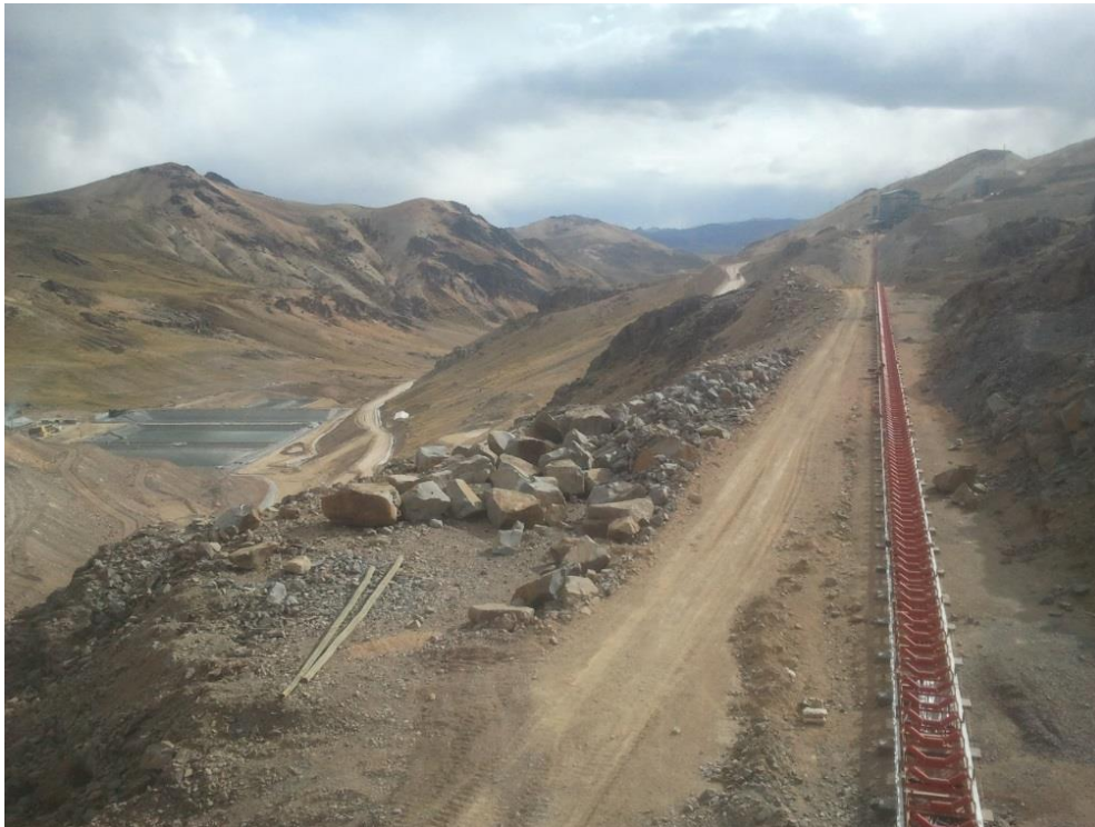
Imagen N°37: Vista de los trabajos de instalación de la faja transportadora, instalación de bases y polines.
