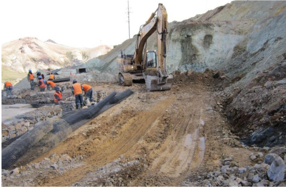
Imagen N°23: Vista de los trabajos de construcción de armado de muros de gaviones, fila 03 (trabajo realizado manualmente complementado con maquinaria pesada).
