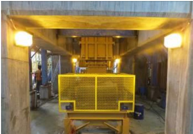
Faja CV-04: Terminado y probado iluminacion en accesos
