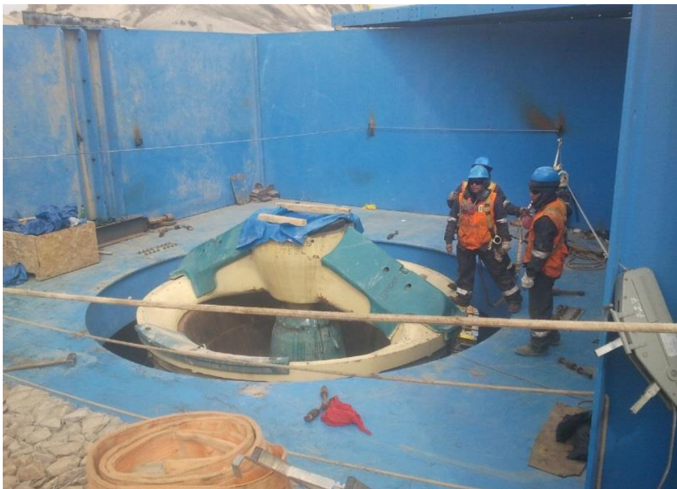
Imagen N°36: Vista de los trabajos de instalación de la máquina de chancado primario de campana. Trabajadores de Cemprotech.
