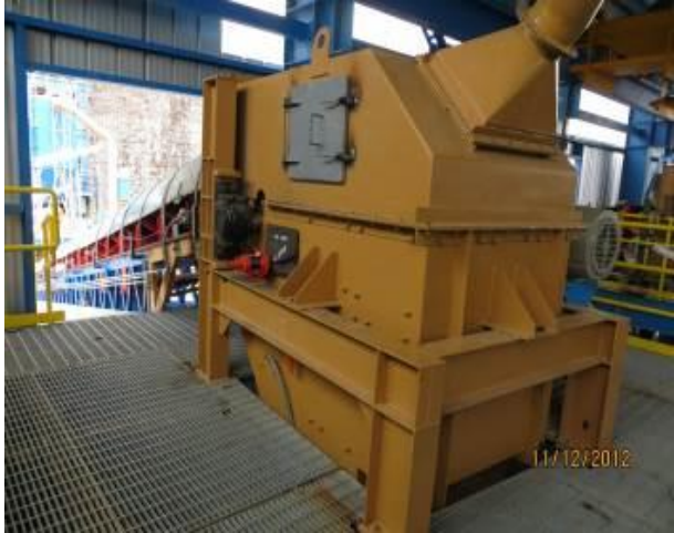
Tolva de descarga de Faja CV-03, Terminado
