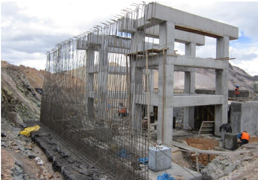
Imagen N°26: Vista de los trabajos de armadura del muro de contención mencionado entre las dos plataformas (diseñado por ingeniería Arasi).
