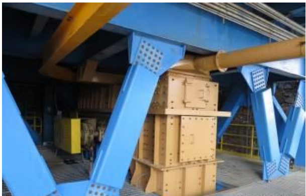
Salida de Ducto de colector de polvo de Aprom Feeder, termiando y probado
