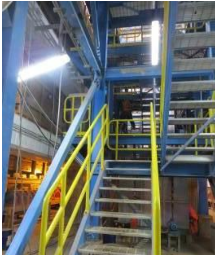
Torre de escalera en ECHS, terminado y probado luminarias en accesos y Techo
