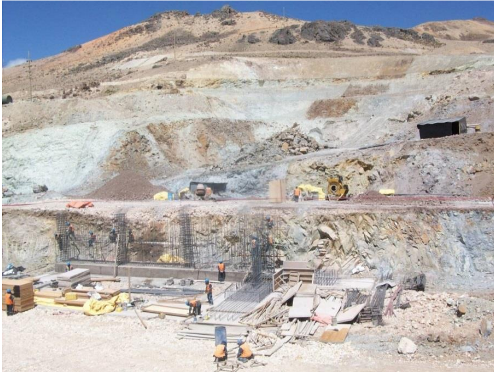
Imagen N°22: Ubicación de los trabajos de excavaciones masivas
