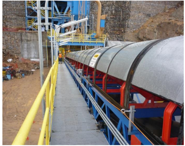
Faja CV-03: Pintado de estructuras
