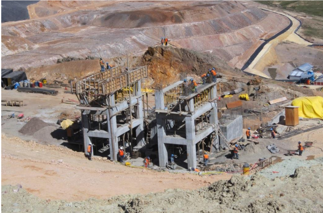
Imagen N°31: Vista de los trabajos de concreto armado en la chancadora secundaria, en primer plano el edificio de la zaranda.
