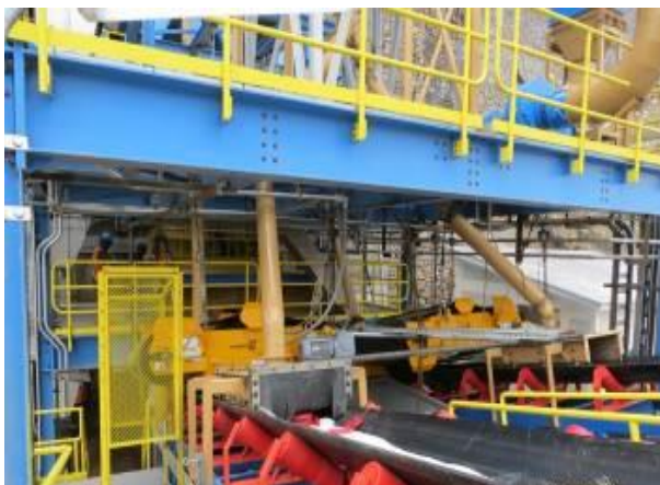
Faja CV-03: Terminado y probado en vacio, falta con carga
