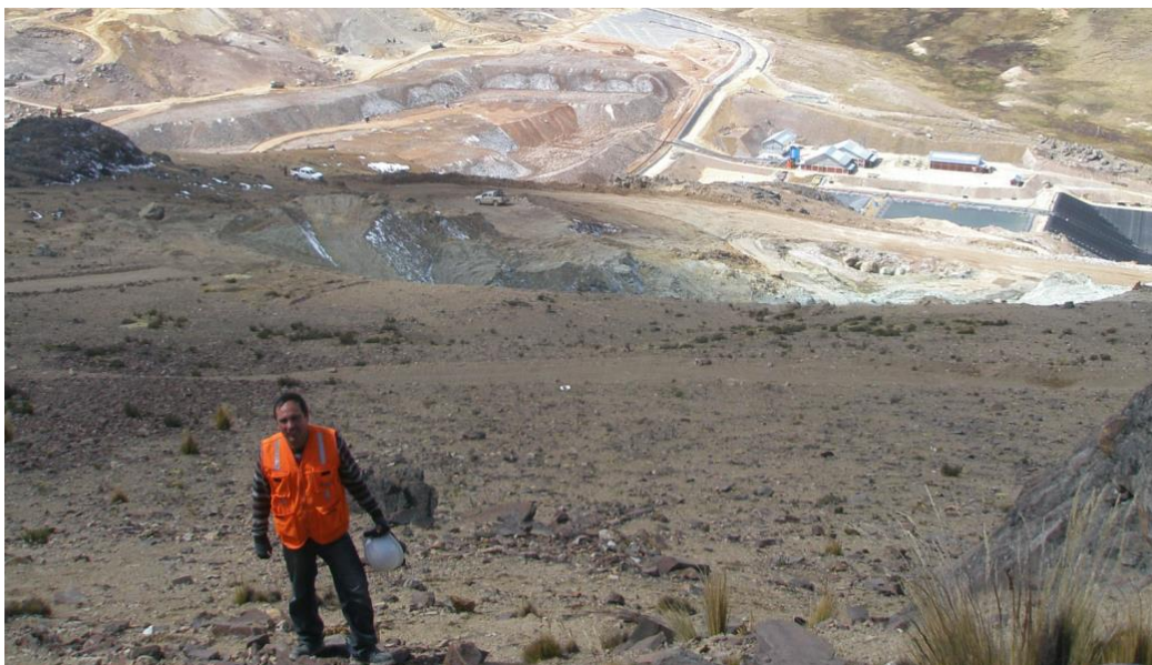
Imagen N°19: Ubicación de los trabajos de excavaciones masivas
