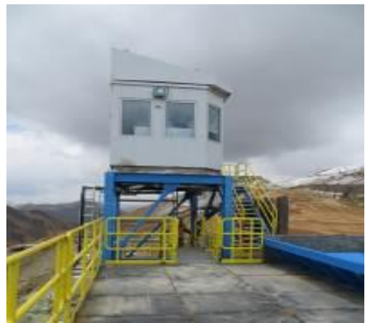
Sala de Control de CHP: Terminado y conexionado
