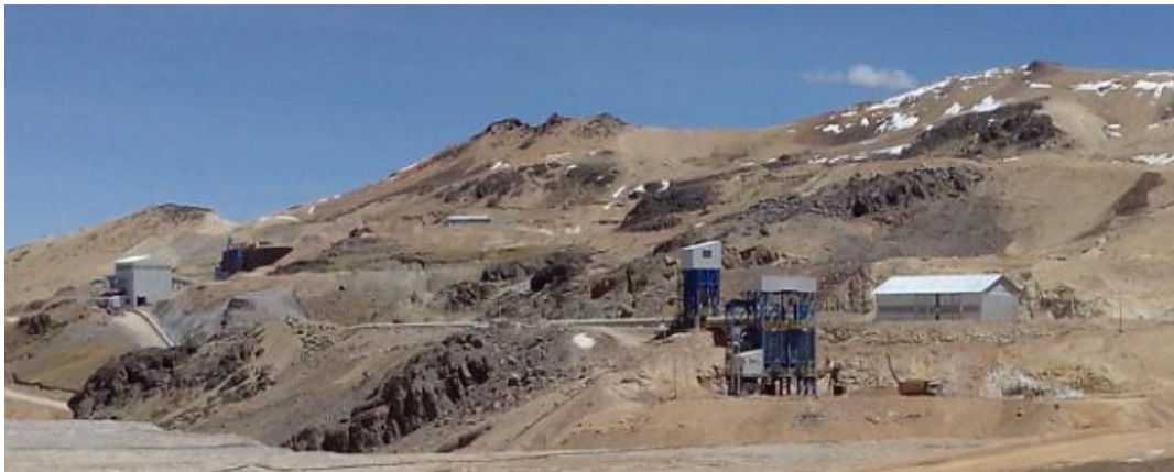
Imagen N°3: Vista de la planta de Chancado
