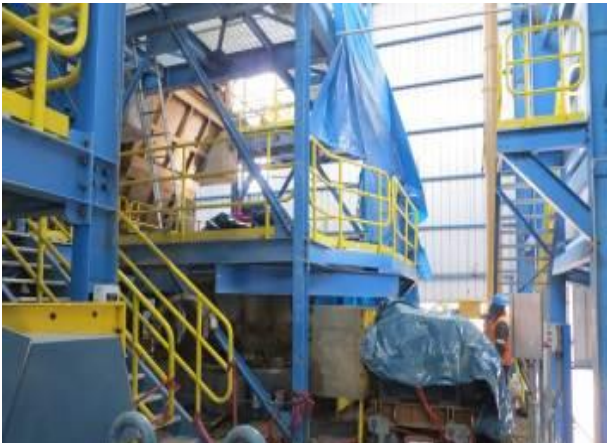
ECHS: Montaje de plataformas y CHS
