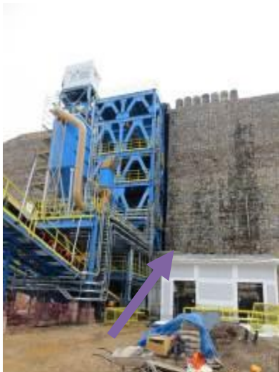
Sala de compresor exterior
