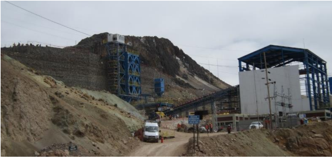
Imagen N°24: Vista de la construcción de muro de gaviones en la fila 15 de 19(altura total 18.10metros)
