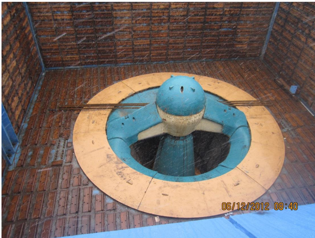
Imagen N°9: Tolva de gruesos-Equipo giratorio de chancado 42" x 65" de 400pm.
