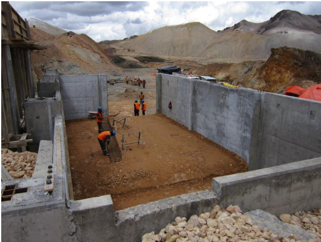
Imagen N°31: Vista de los trabajos de concreto armado en la chancadora secundaria, en primer plano el edificio de la zaranda.
