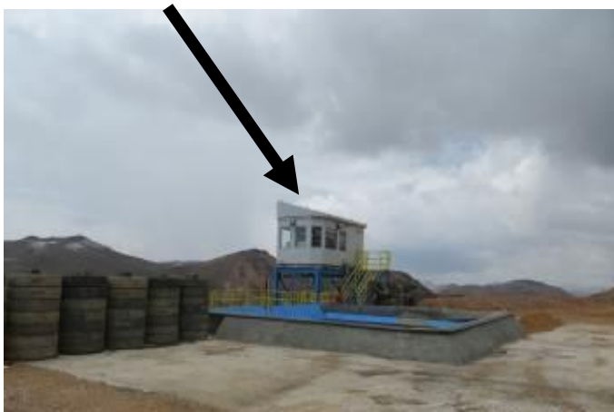
Sala de Control de CHP, exterior
