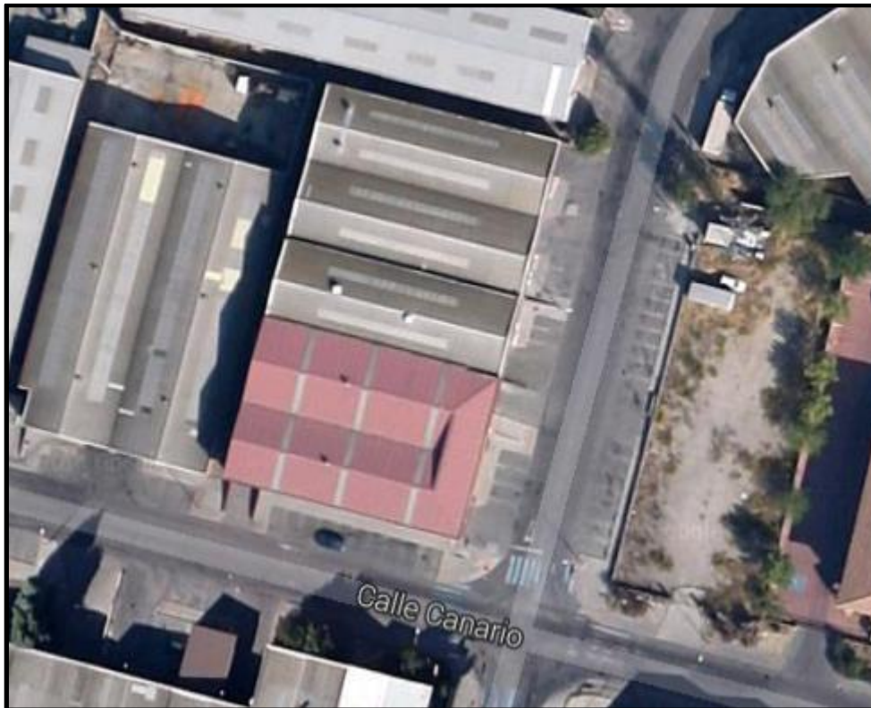
Figura 31. Almacén Central - Almacén 1
