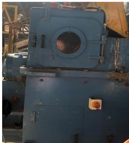
Figura N° 25 Cámara de Vacío de Extrusora Bonfanti
