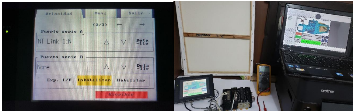
Figura N° 66 Confirmación de Comunicación PLC-HMI
