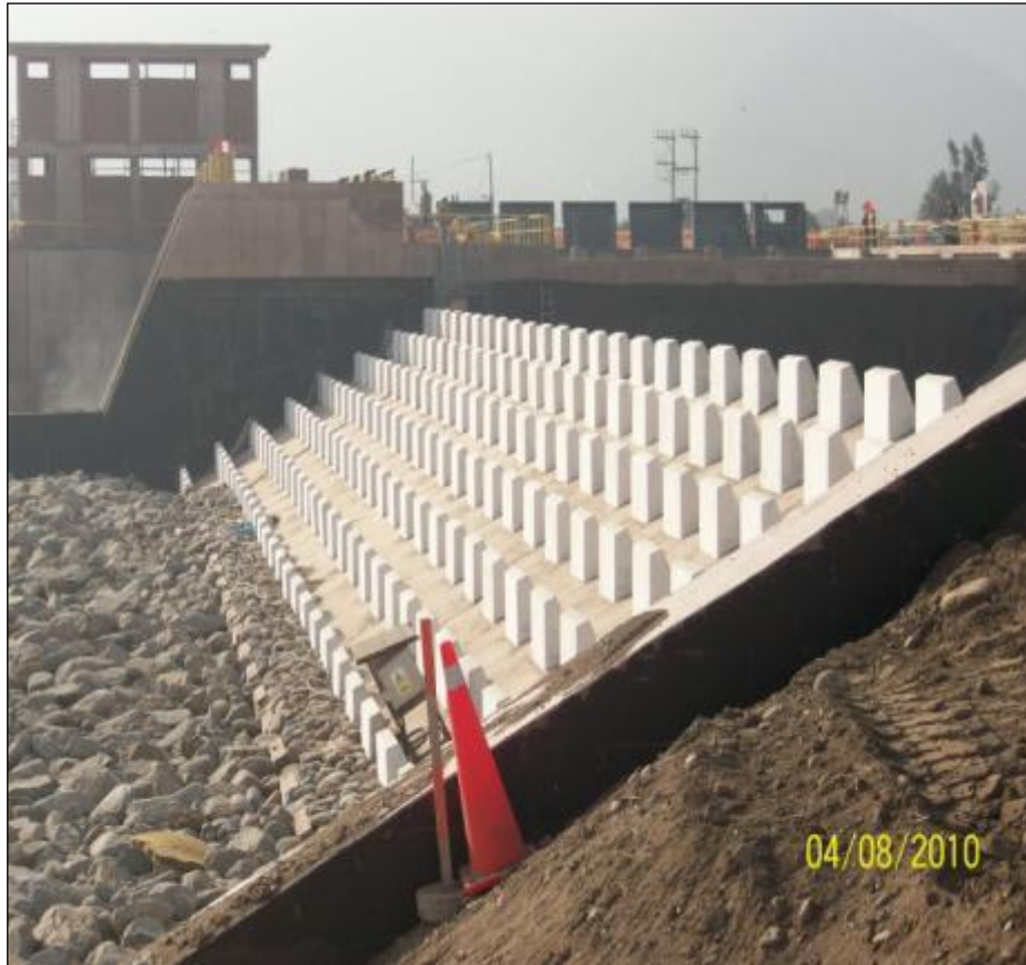
Figura 51: Vista General de Aliviadero Fijo Finalizado Fuente: Registro Fotográfico de Obra
