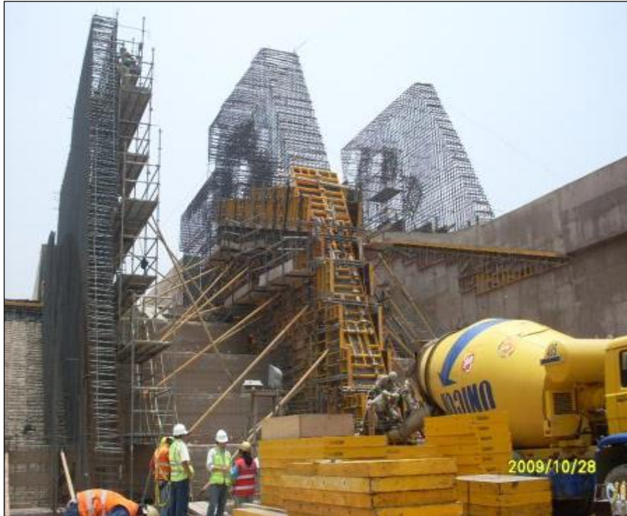
Figura 42: Encofrado en Muros del Aliviadero
