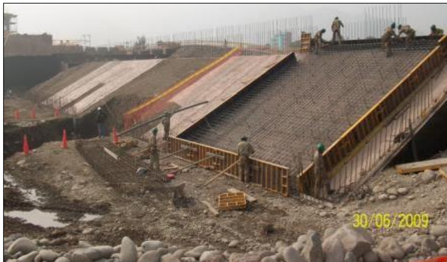
Figura 49: Losas de Aliviadero Fijo Fuente: Registro Fotográfico de Obra
