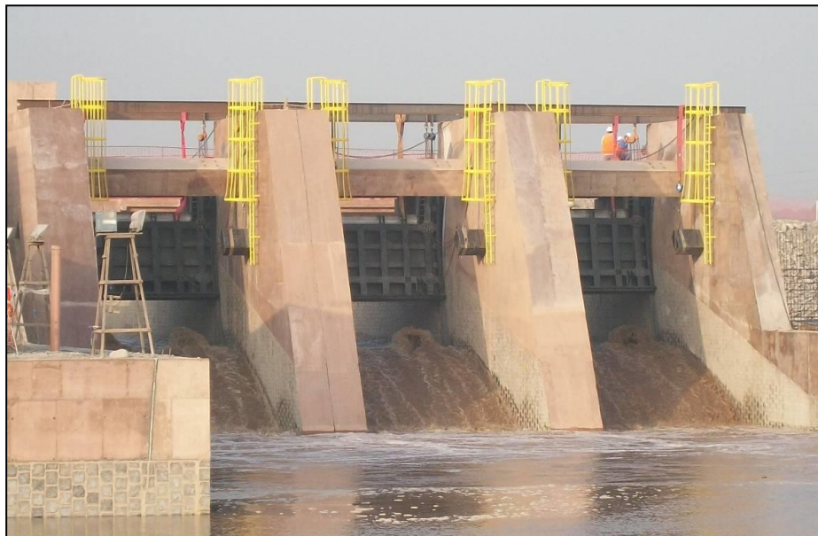
Figura 07: Estructura de Regulación aguas abajo Fuente: Registro Fotográfico de Obra
