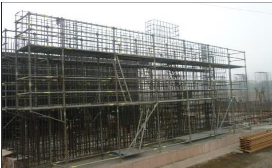
Figura 29: Armado típico de acero de refuerzo en muros
