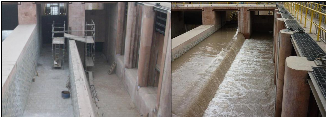
Figura 11: Canal Desripador en Construcción y en Funcionamiento
