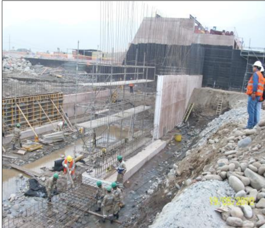
Figura 48: Muros de Aliviadero Fijo
