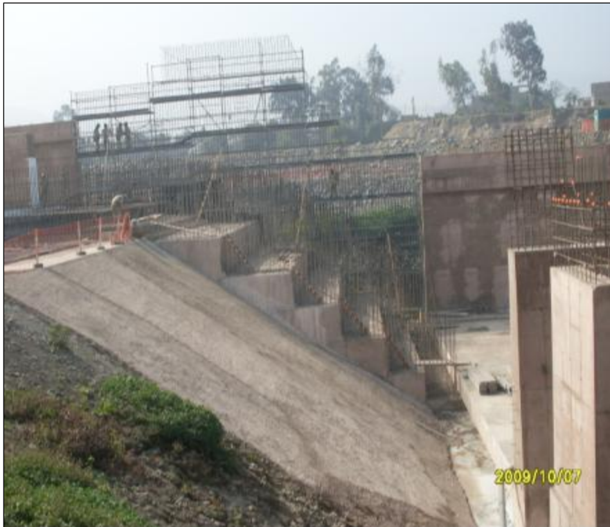
Figura 40: Vaciado de Primera Fase en Vertedero
