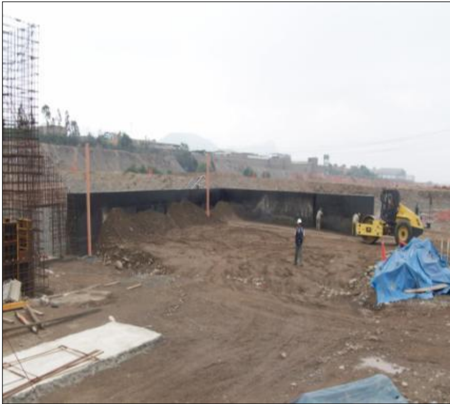
Figura 21: Rellenos Margen Derecha
