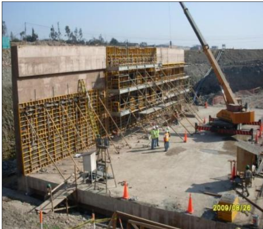
Figura 37: Desencofrad de Muros de Poza de Disipación
