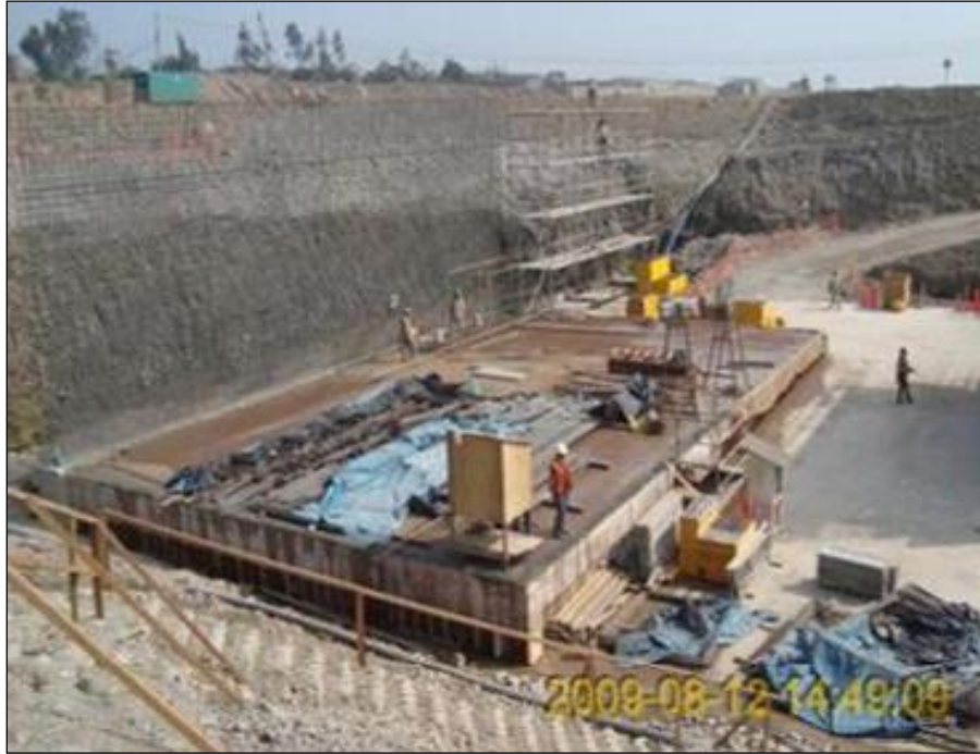
Figura 35: Armado de Acero de Poza de Disipación
