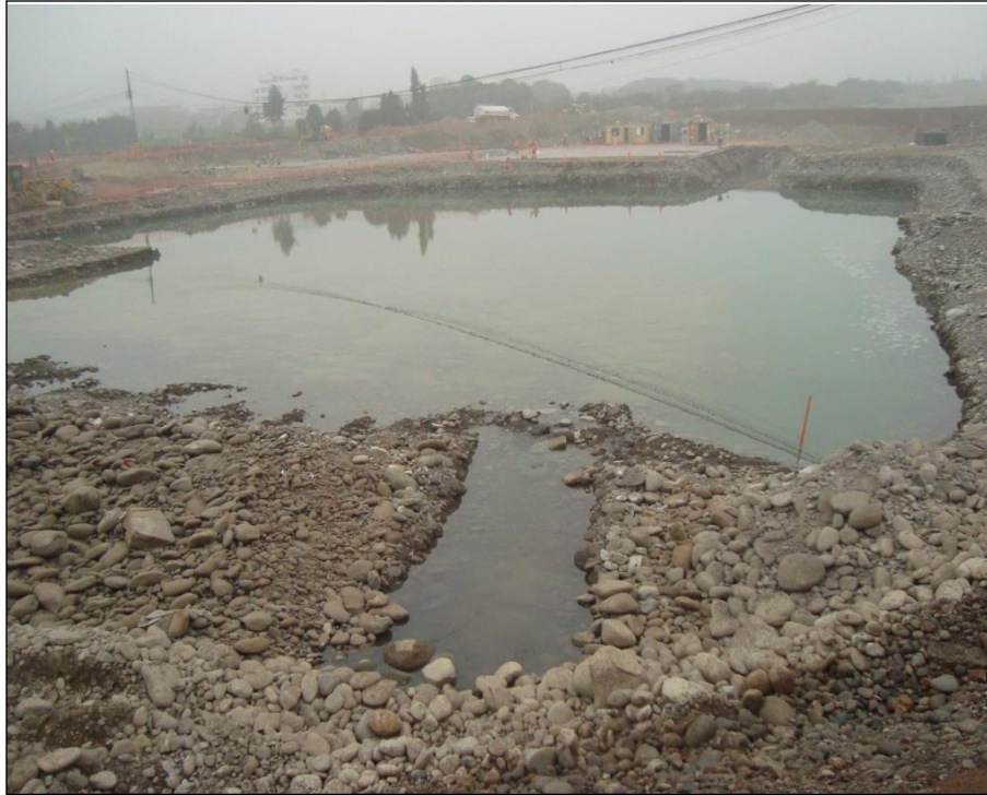
Figura 20: Excavación Poza de Disipación
