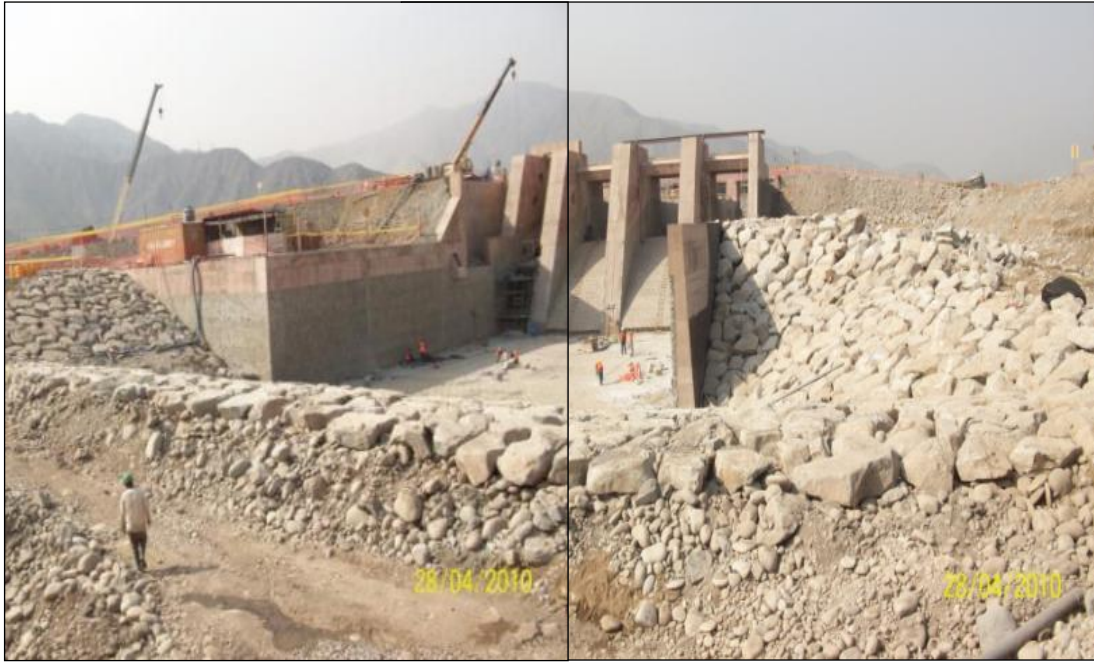
Figura 22: Enrocado en Poza de Disipación
