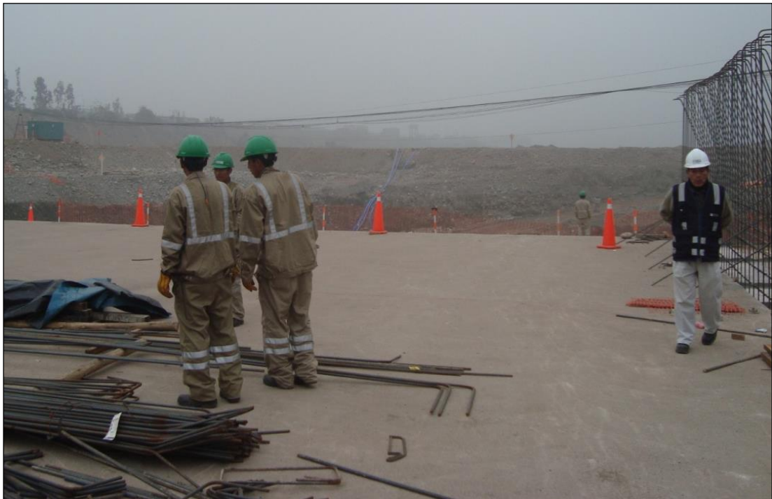
Figura 24: Solado en Canales de Ingreso
