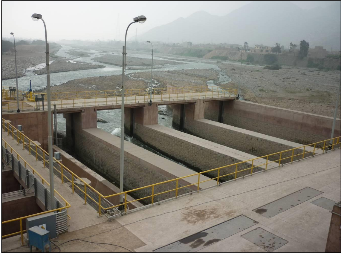
Figura 06: Canales de Ingreso Fuente: Registro Fotográfico de Obra
