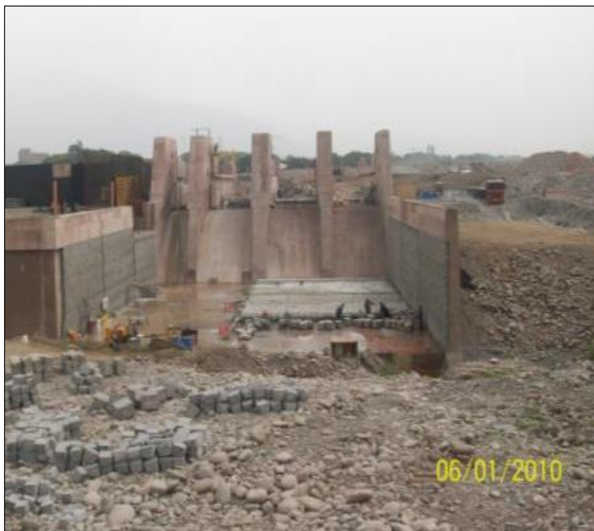
Figura 45: Vista General de Poza de Disipación
