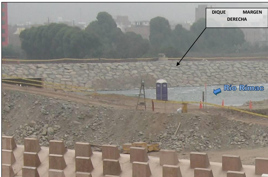
Figura 15: Vista del dique margen derecha
