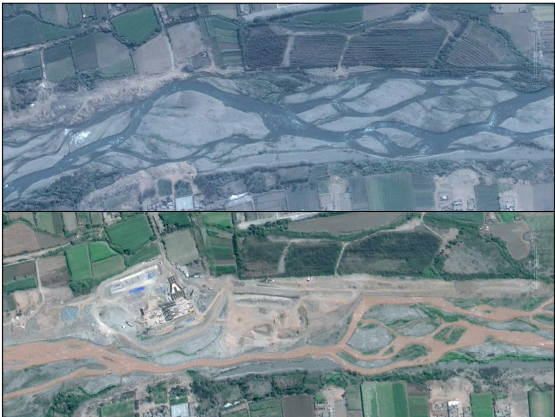
Figura 19: Vista General Antes y Durante la Construcción
