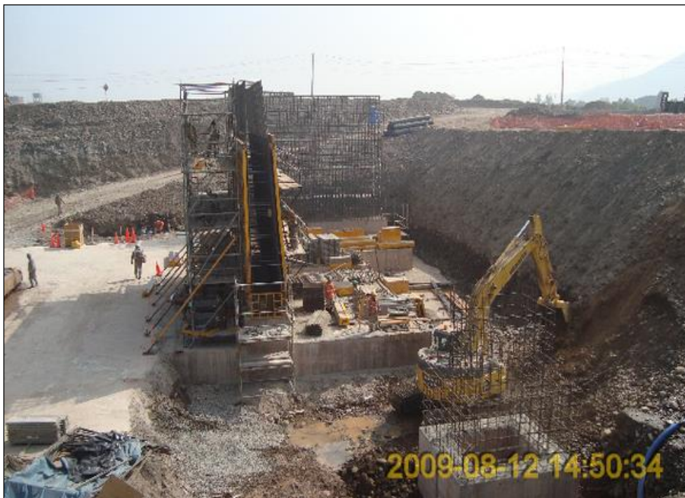
Figura 33: Muros de la Poza de Disipación
