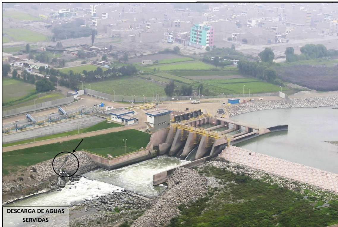
Figura 18: Vista desde aguas abajo Fuente: Expediente Técnico de Obra
