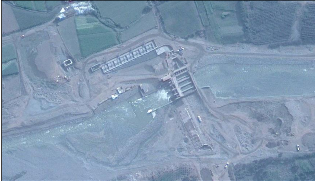
Figura 46: Vista General Bocatoma
