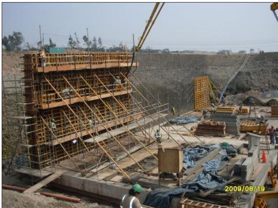
Figura 36: Vaciado de Muros de Poza de Disipación
