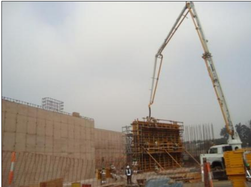
Figura 25: Vaciado de Estructuras
