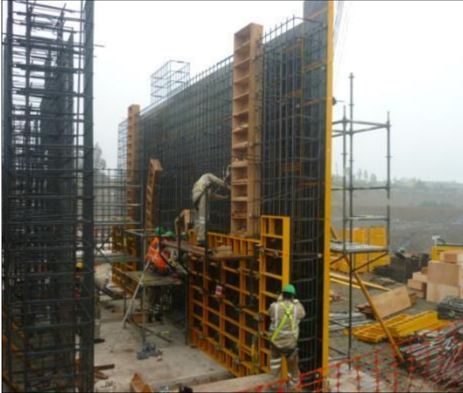
Figura 31: Encofrados con detalle de los Insertos
