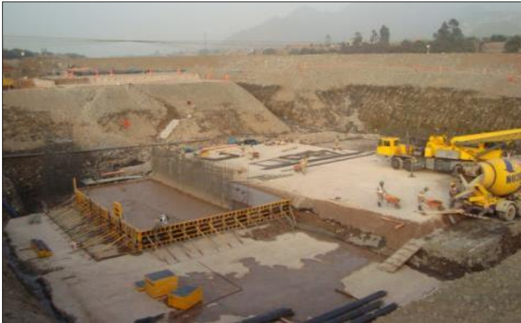
Figura 28: Losas de Concreto en Poza de Disipación
