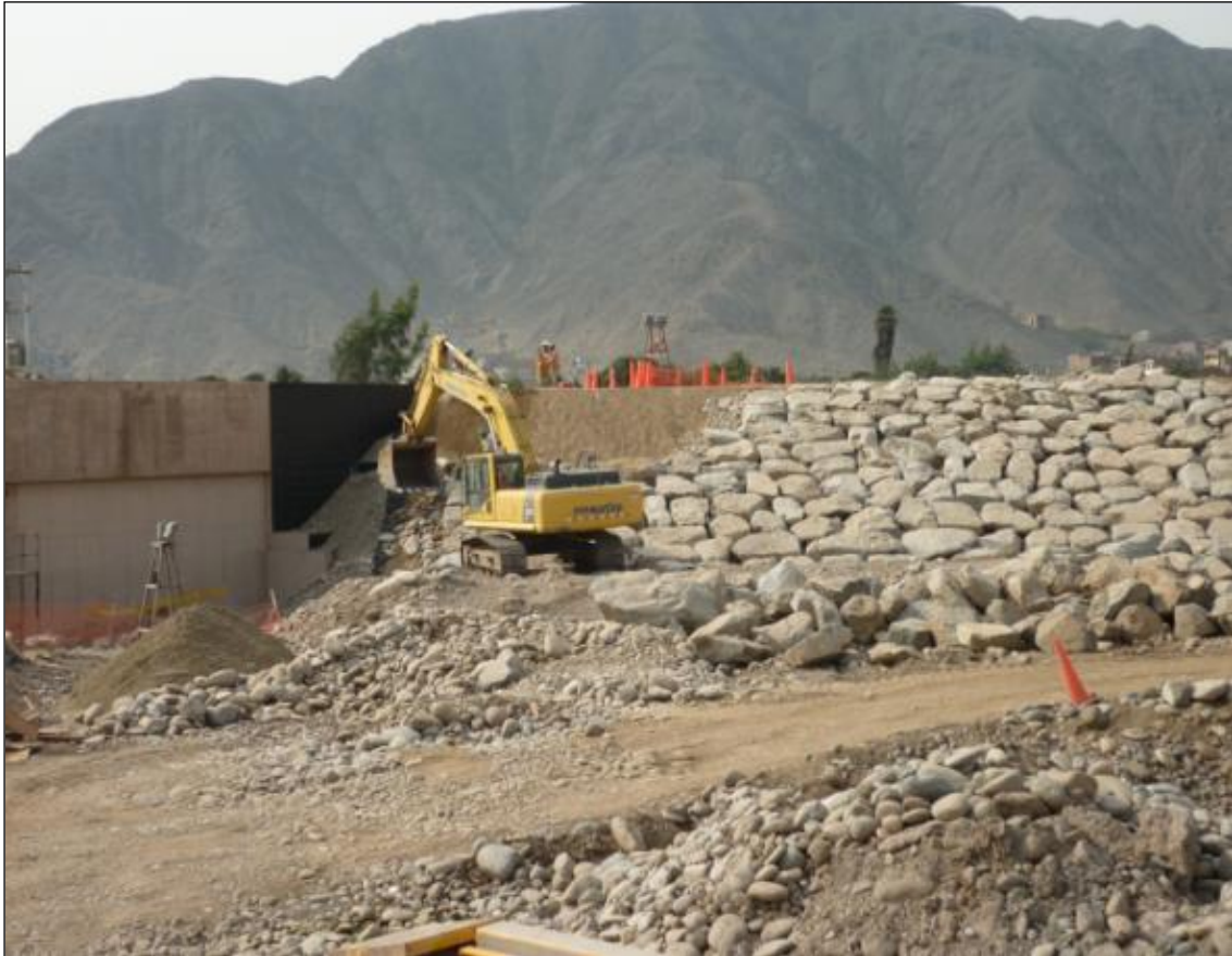
Figura 23: Enrocado Aguas Arriba Margen Derecha Fuente: Registro Fotográfico de Obra
