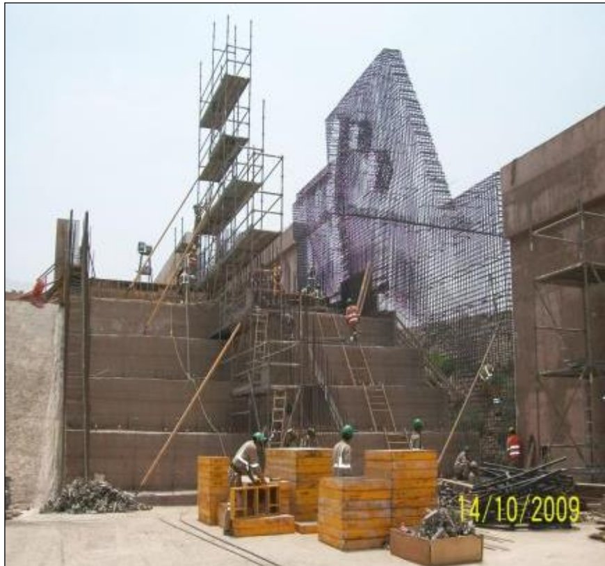
Figura 41: Armado de Acero en Muros del Aliviadero
