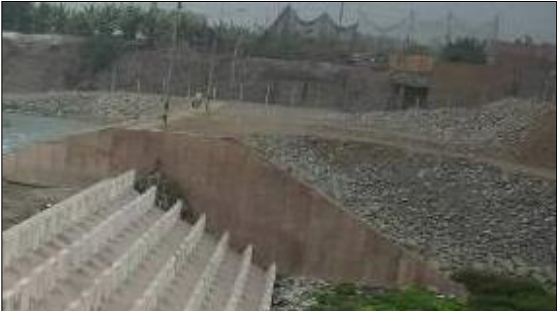
Figura 10: Presa No Vertedora Fuente: Registro Fotográfico de Obra
