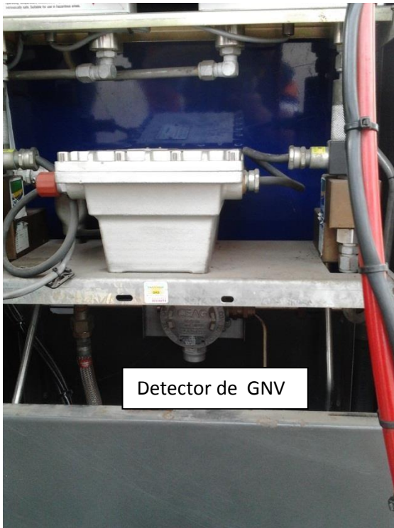
Figura 1.4 Detector de GNV instalado debajo de surtidor GNV.
