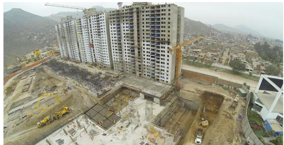
Figura N°01 Construcción de vivienda de interés social
