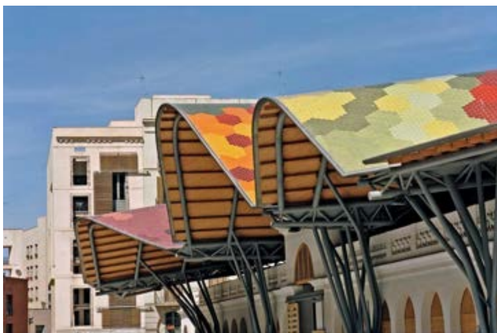
Fotografía 13: Vista de la cubierta de Santa Caterina
