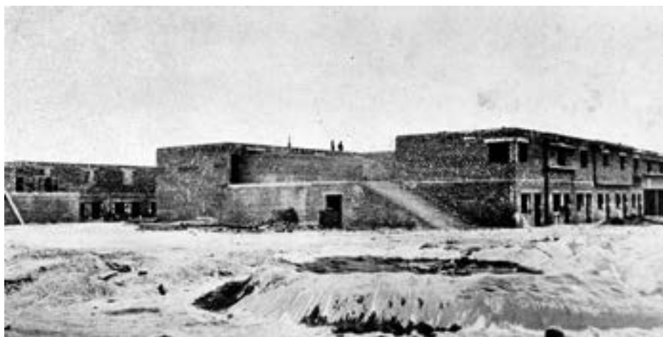
Fotografía 4: Construcción del barrio obrero
