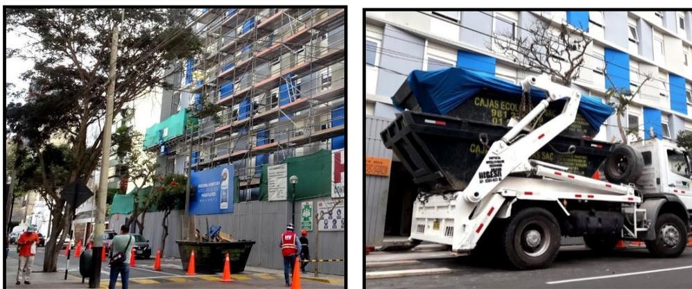
Figura 30: Proceso de recolección de residuos sólidos de construcción
