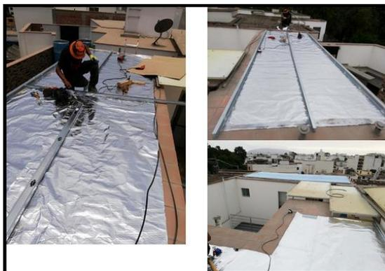
Figura 23: Lámina de Foil de aluminio
