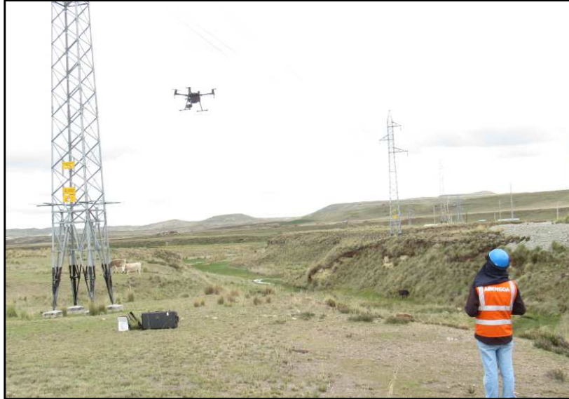
Figura 14: Realización de inspección con RPA (dron)
