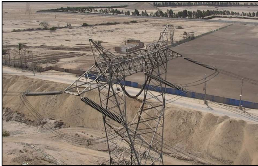
Figura 15: Captura de video de prueba inspección con RPA
