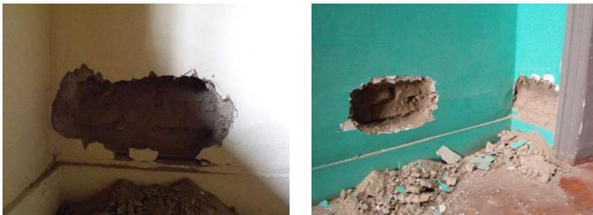
*Figura 32.* Cala en paredes interiores.
