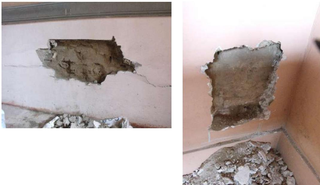
*Figura 31.* Cala en paredes interiores.
