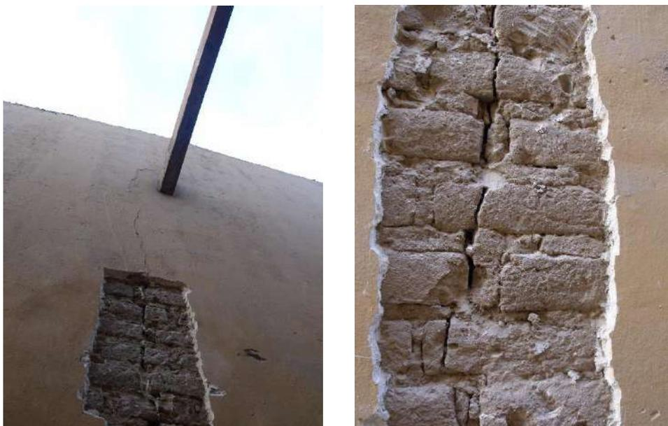
*Figura 36.* Inspección de paredes en pasadizos
