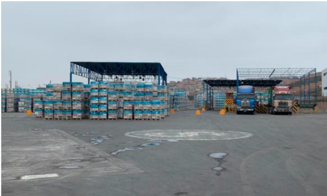
Figura 04: Zona de despacho y patrio de maniobras de APT Fuente: Elaboración propia
