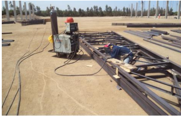
Figura N°36: Soldado de tijerales. Fuente: Proyecto Beta.
