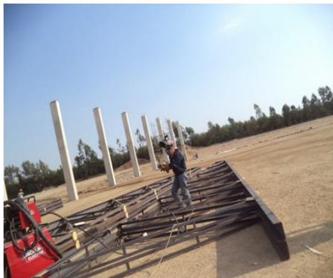
Figura N°35: Apuntalado del armado del tijeral. Fuente: Proyecto Beta.
