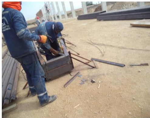
Figura N°34: Armado del tijeral. Fuente: Proyecto Beta.
