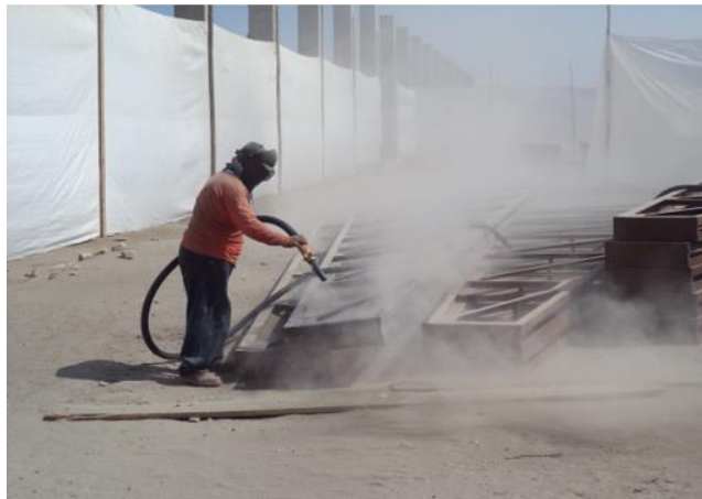
Figura N°37: Arenado de tijerales. Fuente: Proyecto Beta.
