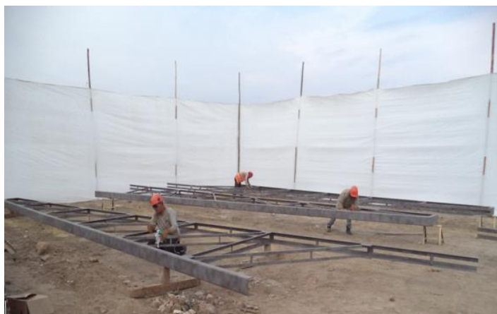
Figura N°38: Limpieza del tijeral despues de arenar. Fuente: Proyecto Beta.
