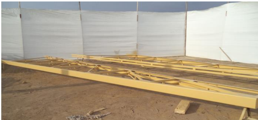
Figura N°41: Pintado final. Fuente: Proyecto Beta
