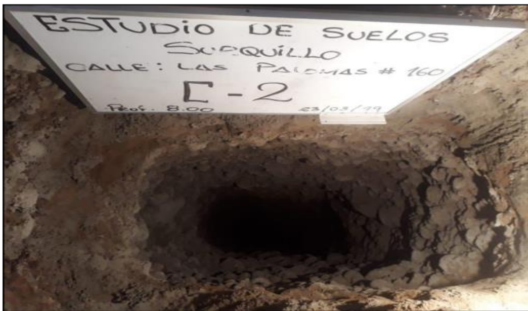
FOTO N° 10: Vista interior de la calicata C-2 donde se muestra el perfil estratigráfico del subsuelo. Se alcanzó una profundidad de exploración de 8.00m. No se encontró la presencia de nivel freático a dicha profundidad.
