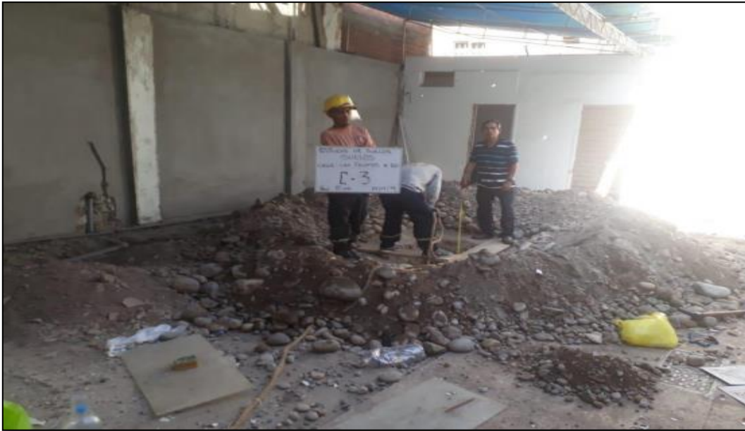
FOTO N° 11: Vista panorámica exterior de la excavación a cielo abierto denominado calicata C-3.
