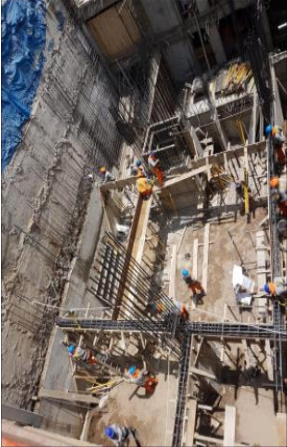
FOTO N° 16: Otra vista de planta de la cimentación en ejecución.
