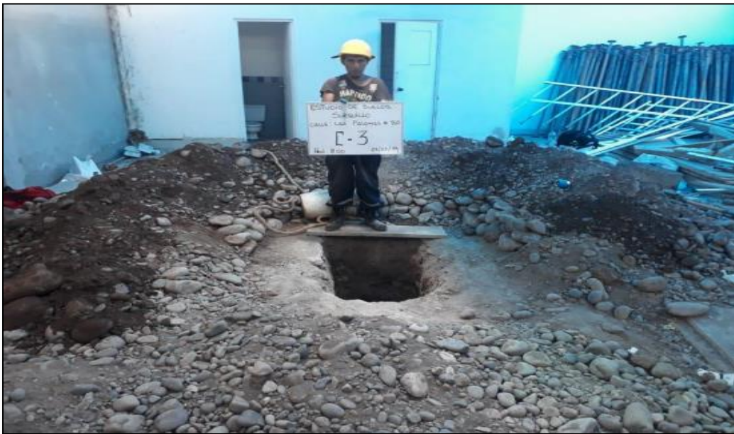
FOTO N° 12: Otra vista panorámica exterior de la excavación a cielo abierto denominado calicata C-3.
