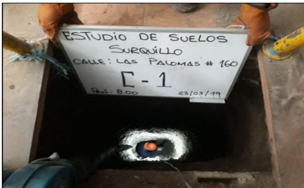
FOTO N° 5: Vista interior de la calicata C-1 donde se muestra el proceso de excavación y el perfil estratigráfico del subsuelo, conformado por boleos, cantos, gravas de forma subredondeada con matriz arenosa.
