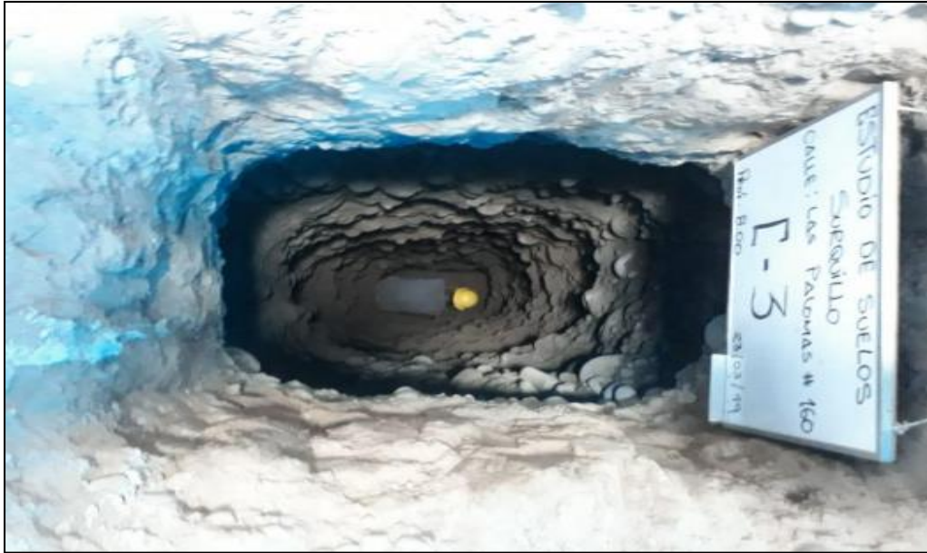
FOTO N° 13: Vista interior de la calicata C-3 donde se muestra el proceso de excavación y el perfil estratigráfico del subsuelo, conformado por boleos, cantos, gravas de forma subredondeada con matriz arenosa.
