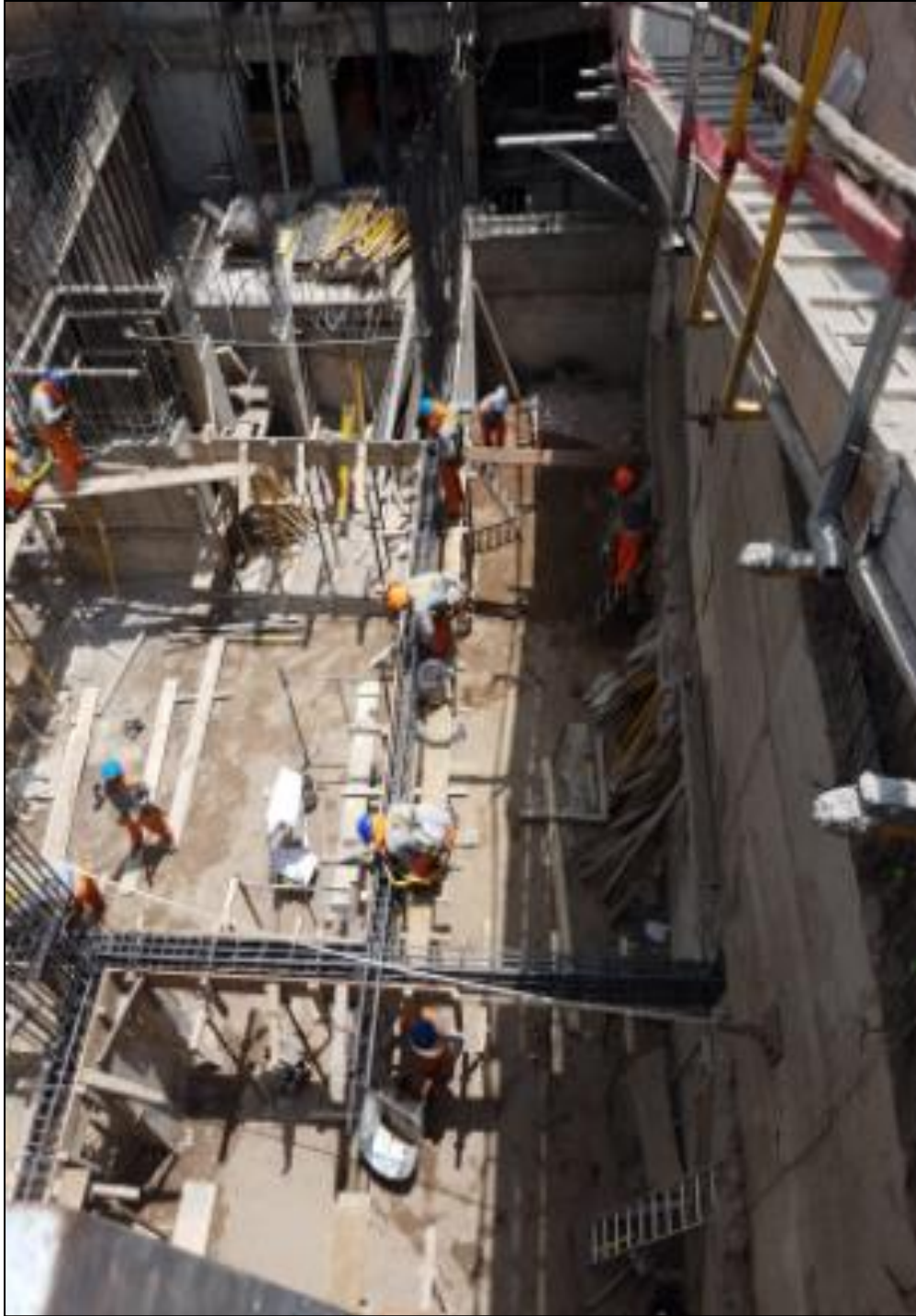
FOTO N° 15: Vista de planta de la cimentación en ejecución.
