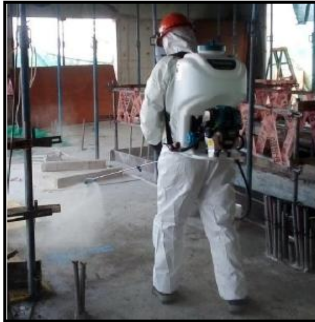
Figura 10: Fumigación de ambientes, Proyecto Ininitum. Fuente: Ing. Arturo Nakandakari - Lider Grupo Constructor
