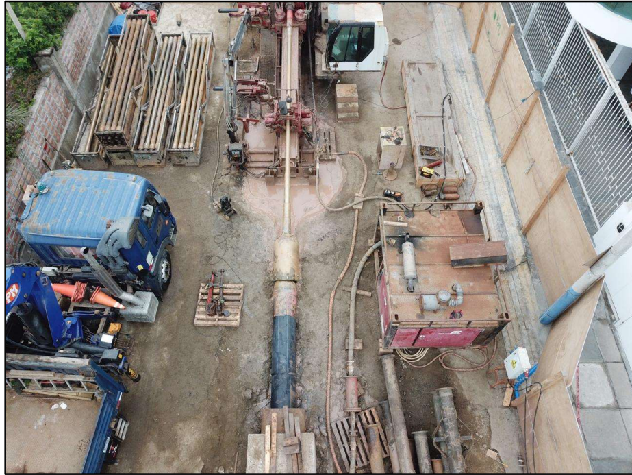
Figura 9: Fin de tiro de tubería
