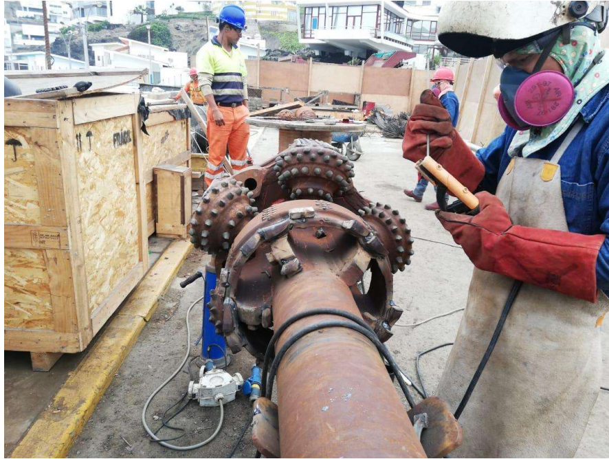
Figura 8: Cabezal direccional (Escariador)
