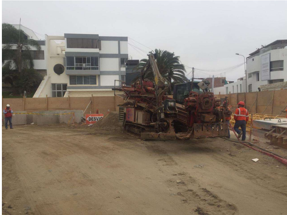
Figura 11: Maquinaria de perforación
