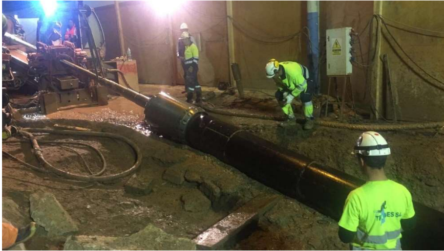
Figura 2: Fin de halado de tubería
