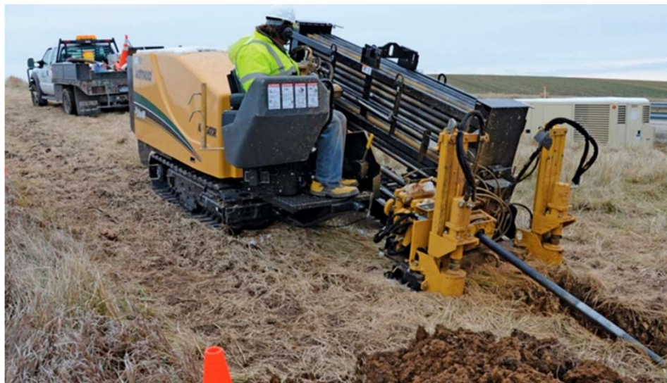
Figura 10: Maquinaria de perforación
