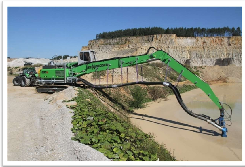
Figura 37: Excavadora con bomba 830 R-HDD, Fuente: Cervirmax
