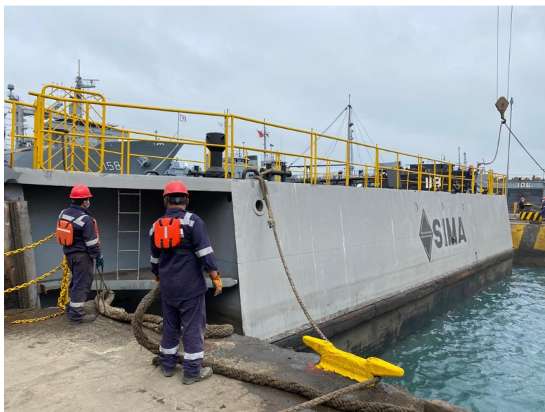
Figura 28. Maniobra de retiro de la compuerta del dique
