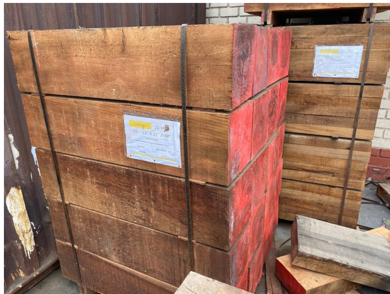
Figura 18. Calzos de madera tipo tornillo
