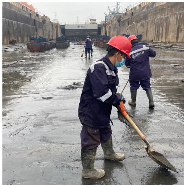
Figura 14. Limpieza general del plan del dique
