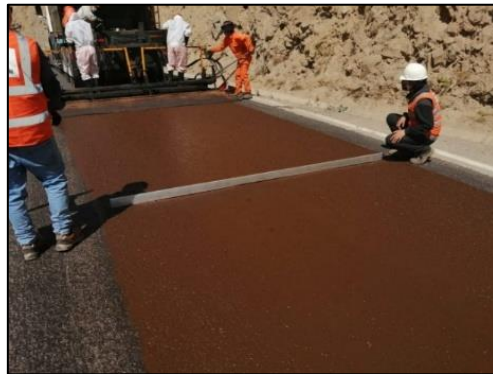
Figura 33: Inspección in situ de la aplicación de micropavimento
