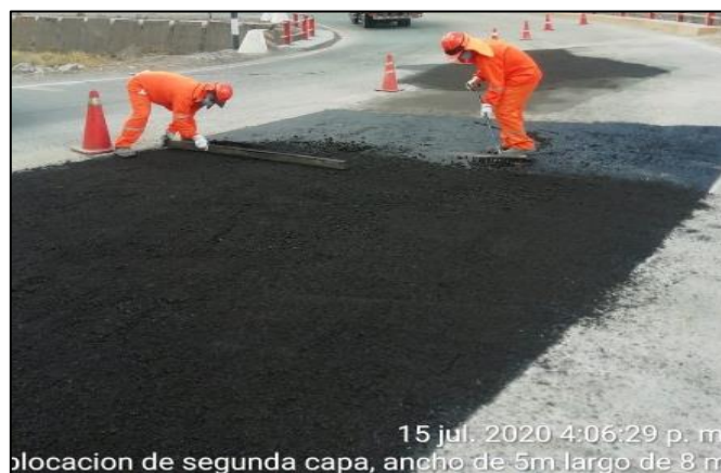
Figura 20: Aplicación de mezcla en frío (Bacheo)
