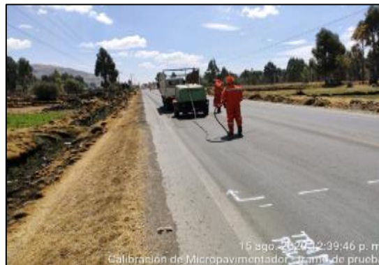
Figura 27: Limpieza de la zona de aplicación con compresora de aire
