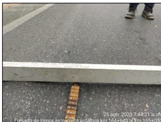
Figura 13: Inspección In Situ del estado de la carpeta asfáltica
