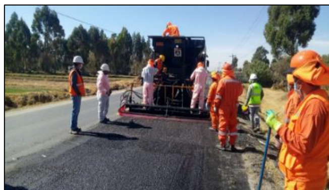
Figura 28: Aplicación de micropavimento
