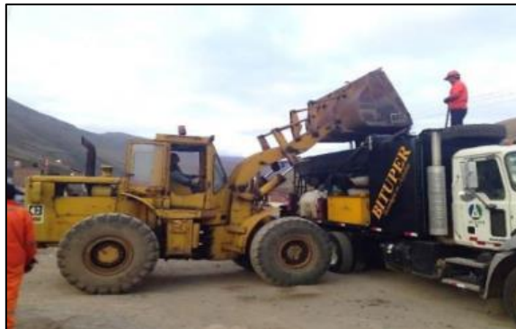
Figura 25: Abastecimiento de material e insumos para micropavimento
