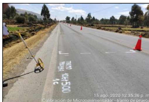
Figura 26: Delimitación de zona de trabajo y aplicación de micropavimento
