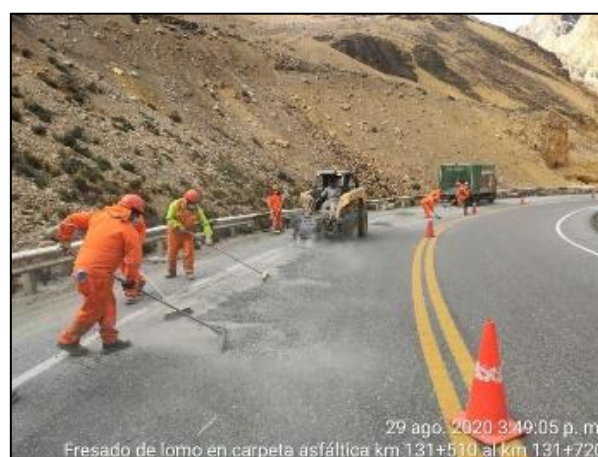
Figura 16: Acumulación y eliminación de material excedente
