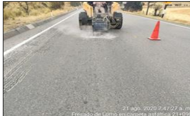
Figura 15: Fresado de lomos con minicargador
