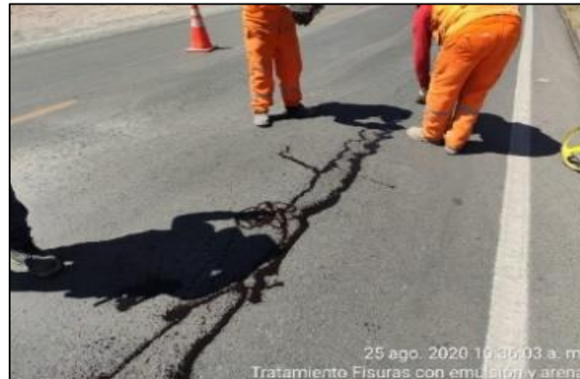
Figura 17: Rocío de emulsión con agua
