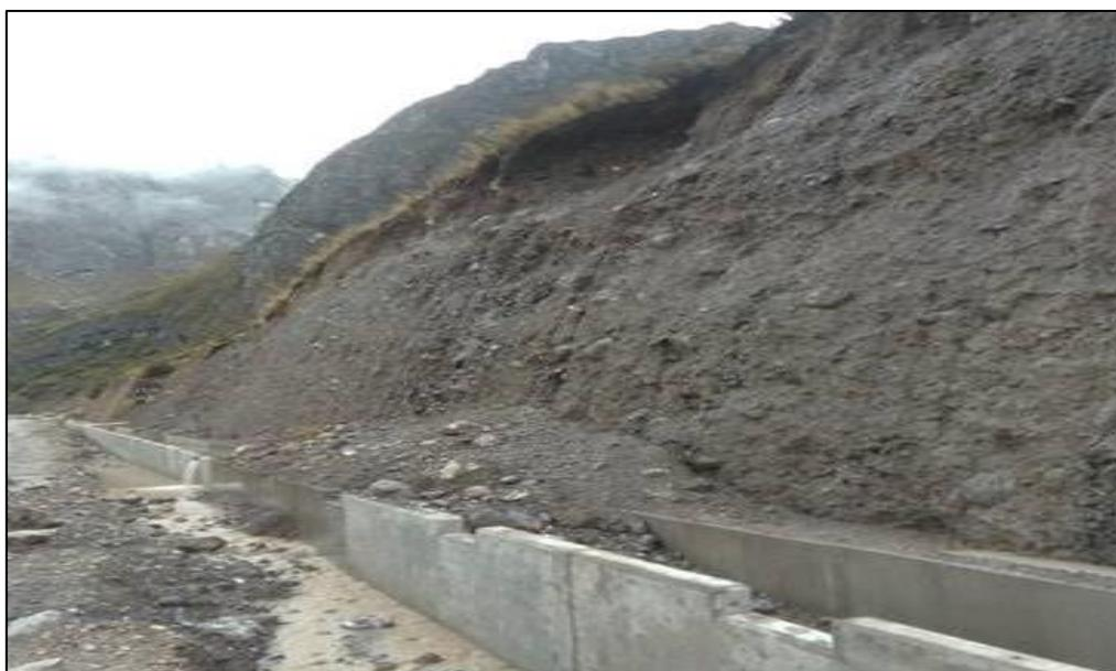
*Nota.* Como se observa en la imagen los taludes de corte en material suelto evidencian inestabilidad en temporadas de lluvias, lo cual afecta a la estructura del canal hidráulico y además puede generar desbordes afectando directamente a la nueva carretera y a los taludes inferiores de los terraplenes, erosionándolo como primera acción y contaminando las lagunas colindantes a la construcción con el ingreso de estas aguas. Elaboración Propia.
