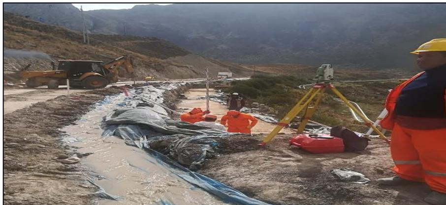
*Nota.* En la imagen se observa el incorrecto desvío temporal de aguas por el revestimiento de rollos de plásticos. Elaboración Propia.
