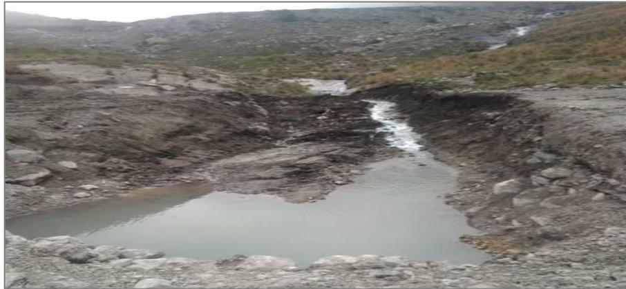
*Nota.* Como se observa en la imagen las infiltraciones de aguas en la excavación de una alcantarilla tipo MCA afectando a el suelo de fundación y la intervención de la construcción. Elaboración Propia.
