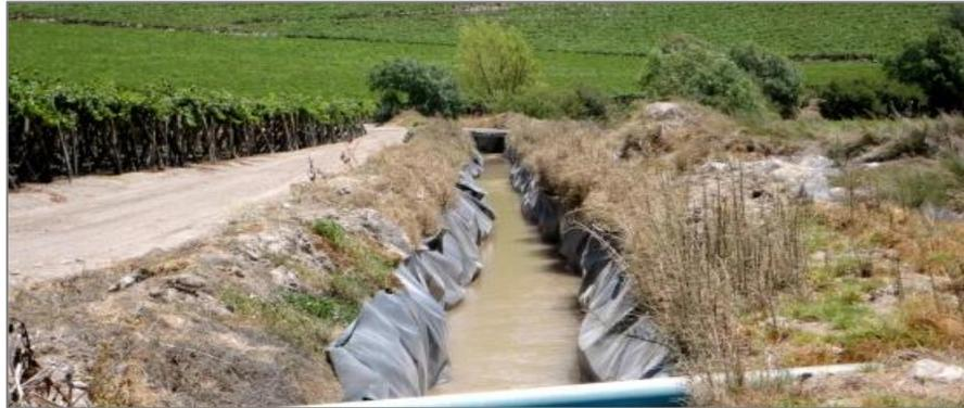
*Nota.* El revestimiento de canal para mitigar las infiltraciones y controlar las contaminaciones de los suelos. Adaptado de *El revestimiento del canal compañía cumple con las expectativas del usuario*, por Canal compañía, 2014, (<https://canalcompania.wordpress.com/2014/01/13/el-revestimiento-del-canal-compania-cumple-con-las-expectativas-de-los-usuarios/>). Todos los derechos de autor.
