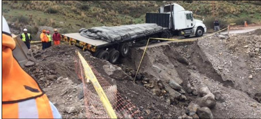
*Nota.* Como se observa en la imagen no se realizó un correcto desvío de las aguas provenientes de las quebradas que garantice su correcto discurrir, generando erosiones y hundimiento en el talud del terraplén. Elaboración Propia.
