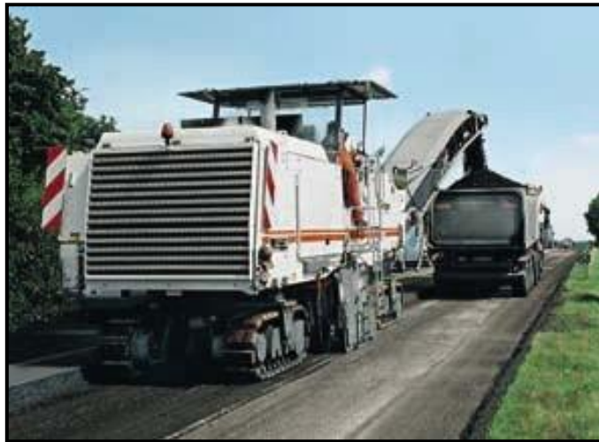
Figura N°8: Fresado de capas asfálticas envejecidas
