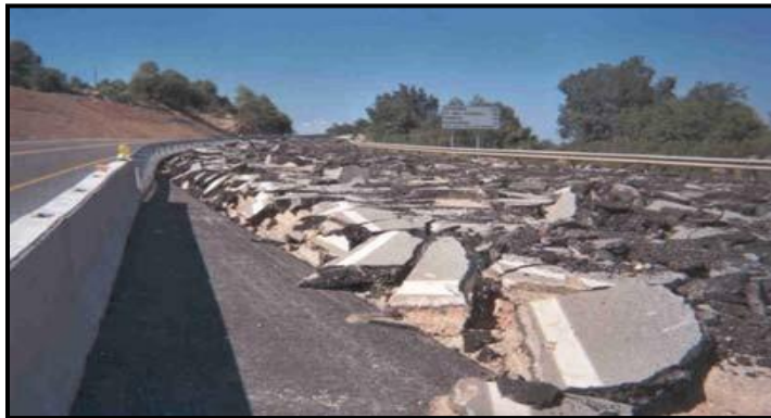
Figura N°7: Demolición mecánica de un pavimento
