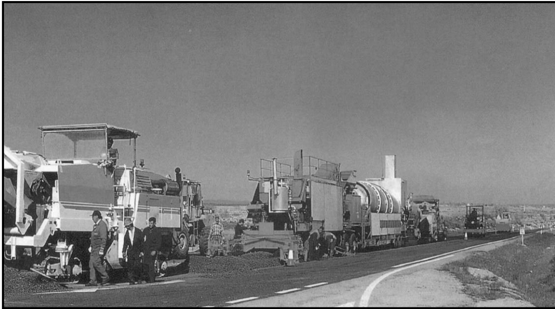
Figura N°6: Maquinaria de tratamiento en caliente in situ
