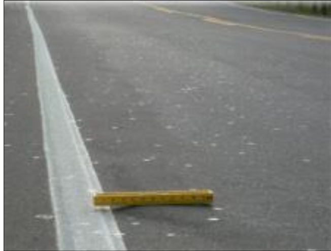
Figura N° 21: Desplazamiento
