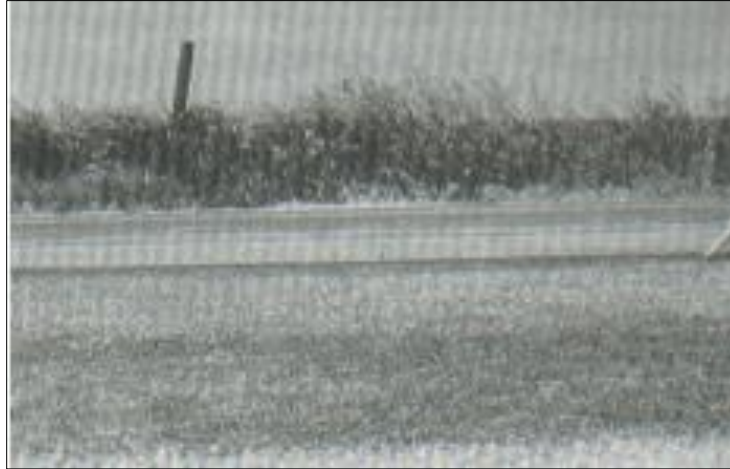
Figura N° 10: Corrugación
