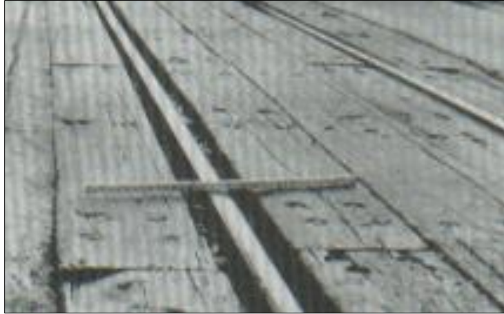
Figura N° 19: Cruce de vía férrea
