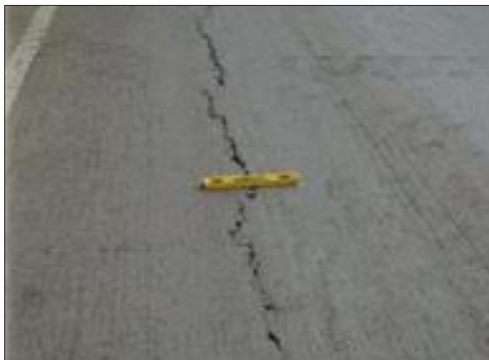
Figura N° 15: Grietas longitudinales
