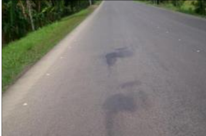
Figura N o 7: Exudación Fuente: (INVIAS, 2007)
