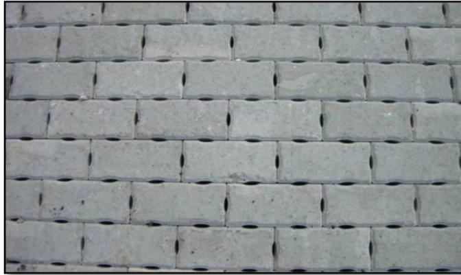
Figura N° 4: Adoquines de bloques con ranuras libres
