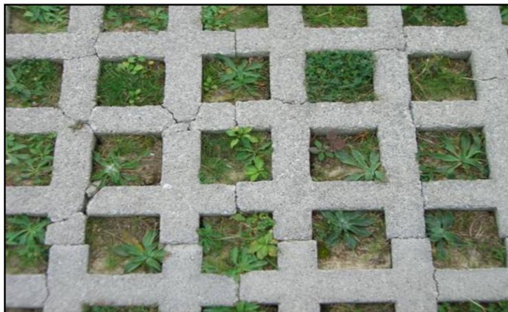
Figura N° 2: Césped con refuerzos de hormigón
