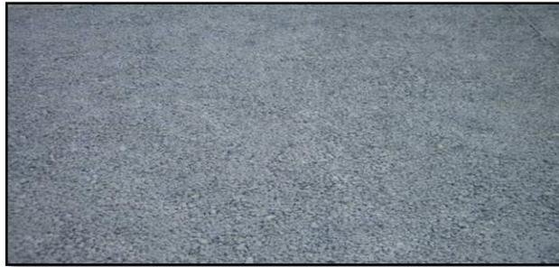
Figura N° 6: Losa de Concreto Hidráulico Poroso
