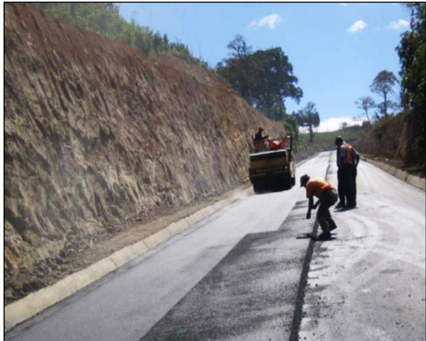
Figura N° 19: Fotografía de Compactación de la Mezcla Asfáltica
