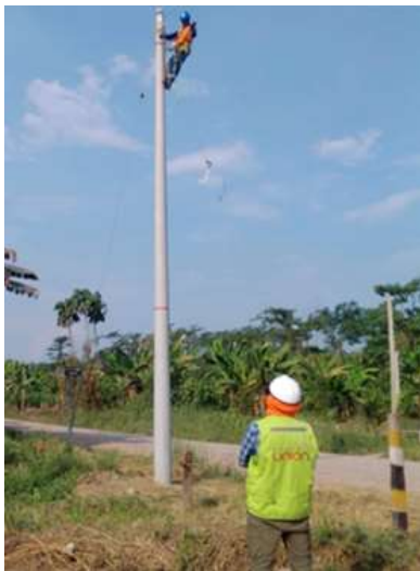
Figura 19: Evidencia fotográfica de la Supervisión de SSTMA - OPT Escalamiento de postes.
