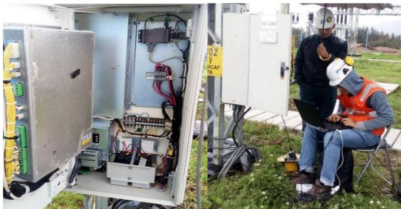
Figura 91. Configuración de reconector para la automatización.
