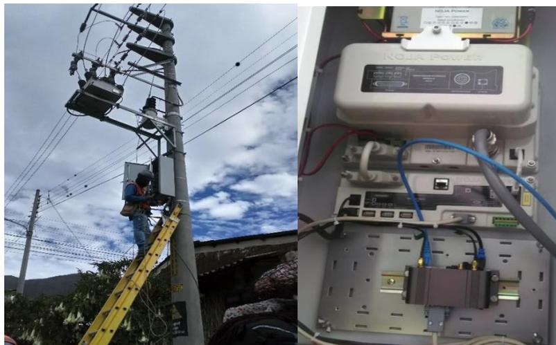
Figura 93. Reconector de marca Noja configurado para la automatización
