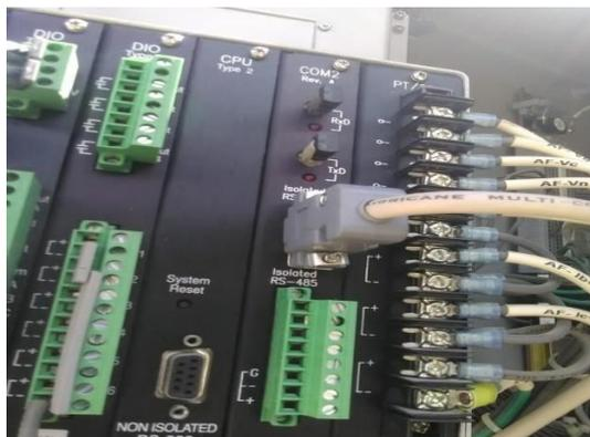
Figura 132. Conexión del cable serial en el reconvertor para restablecer la comunicación
