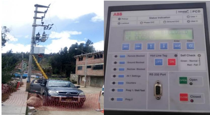
Figura 92. Configuración de reconector en poste para la automatización
