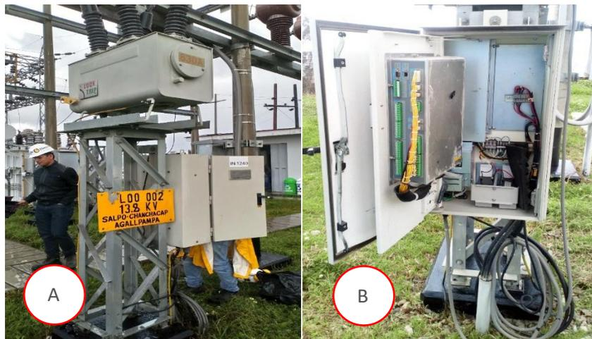
Figura 40. A) Inspección del equipo de reconexión en la subestación eléctrica. B) Revisión del tablero del equipo reconector y medición para la instalación del módem.
