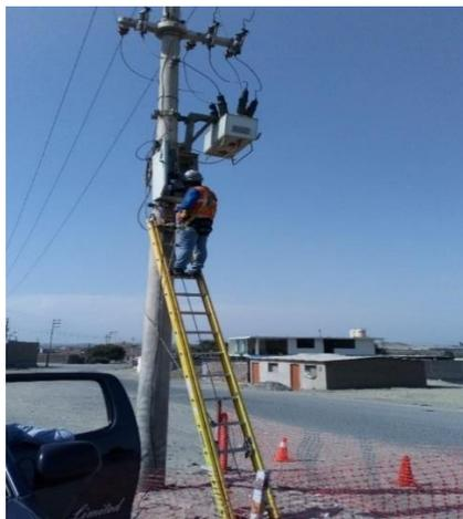
Figura 112. Personal en campo para la prueba de control de apertura y cierre de un reconectador desde el sistema SCADA
