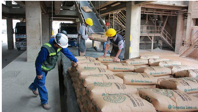
Figura 2: Estibamiento de bolsas de cemento en Empresa UNACEM
