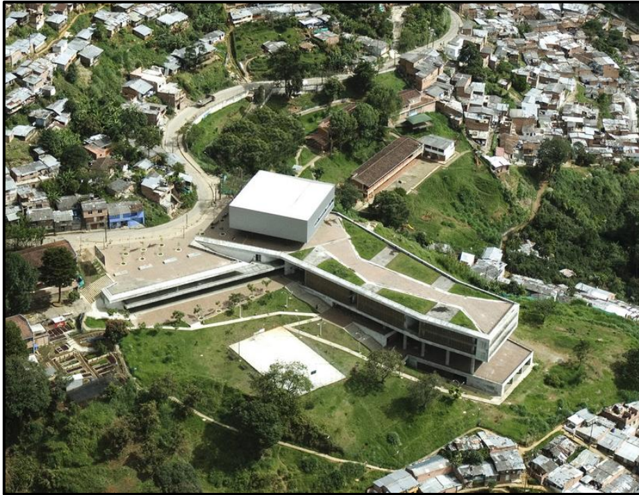
Figura 7. Vista área del colegio
