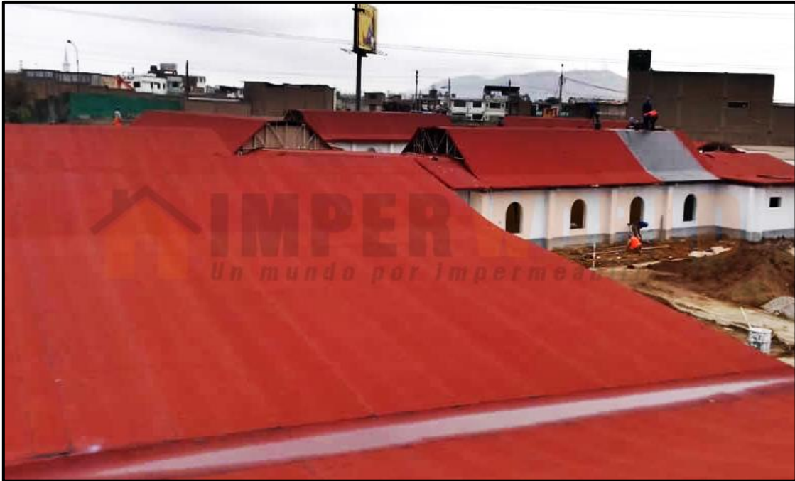
Figura 87. Manto asfáltico en techos
