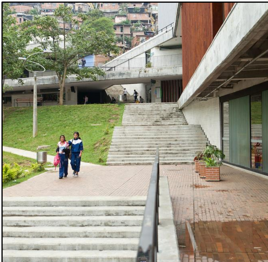
Figura 8. Vista de la escalera
