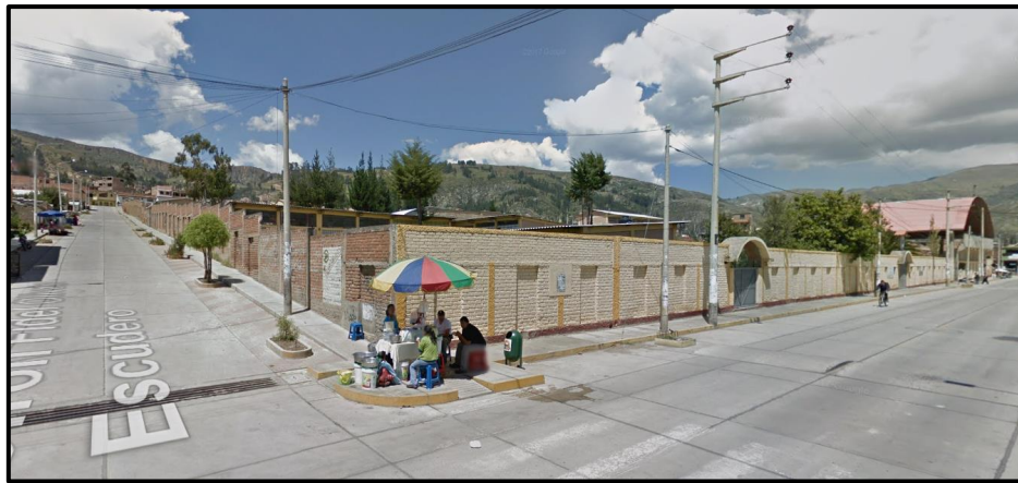
Figura 30. La figura muestra el cruce de Av. Ramón Castilla con Jr. Fidel Olivas. Fuente: Google Street View 2019
