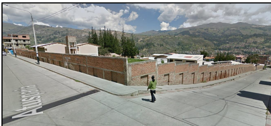
Figura 31. La figura muestra el cruce de Jr. Fidel Olivas Escudero con Av. Atusparia. Fuente: Google Street View 2019
