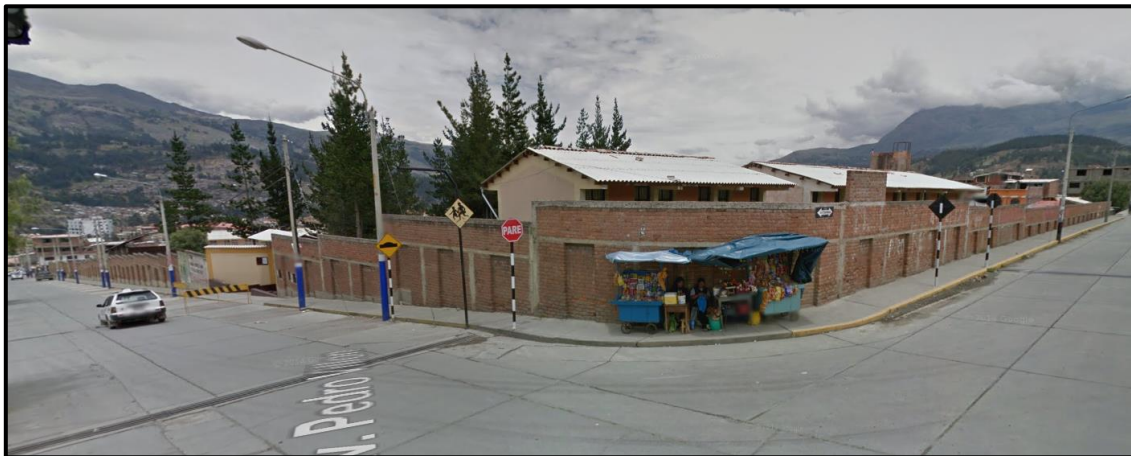
Figura 64. La figura muestra el cruce de Av. Atusparia con Av. Pedro Villón. Fuente: Google Street View 2019
