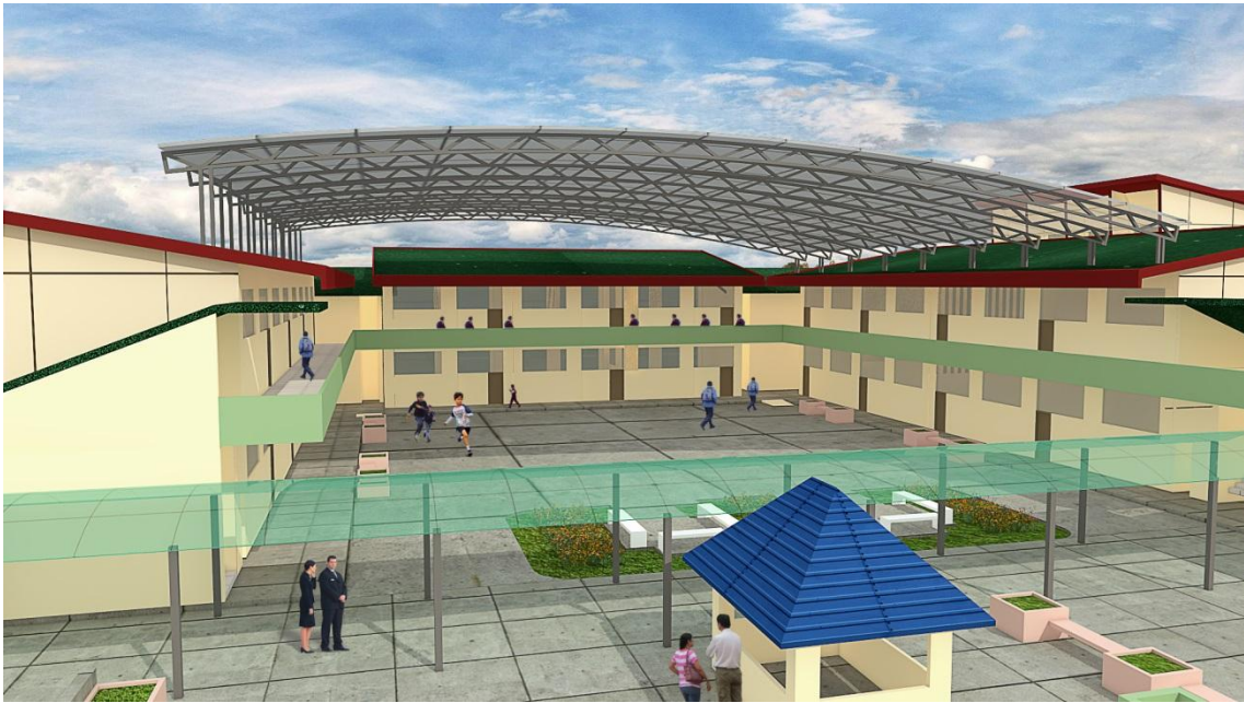
Vista de las Aulas de Secundaria con sus dos niveles, su cobertura metálica y de policarbonato, también se aprecia la pérgola y el kiosko en un primer plano.
