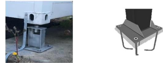
Figura N°50. Placa de Anclaje. Fuente: JVC Shipping.
