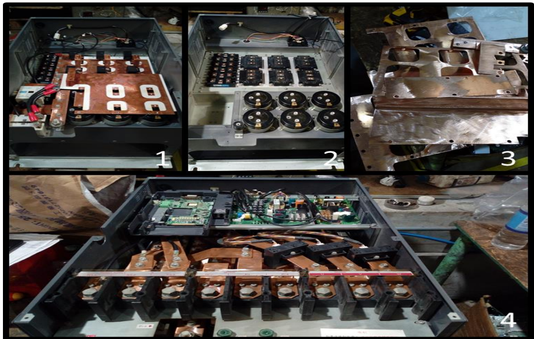
Figura 51. Mantenimiento al Variador Principal
