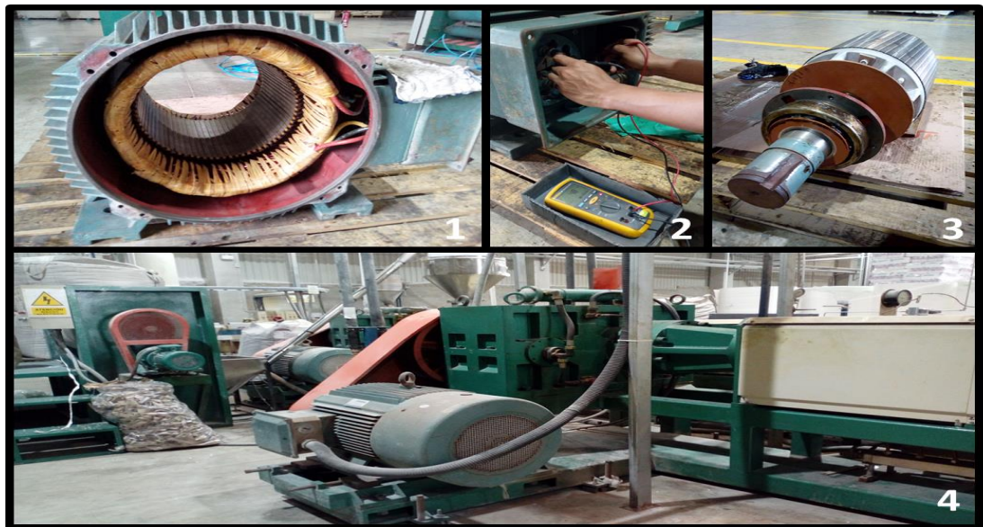
Figura 50. Mantenimiento a los Motores Eléctricos
