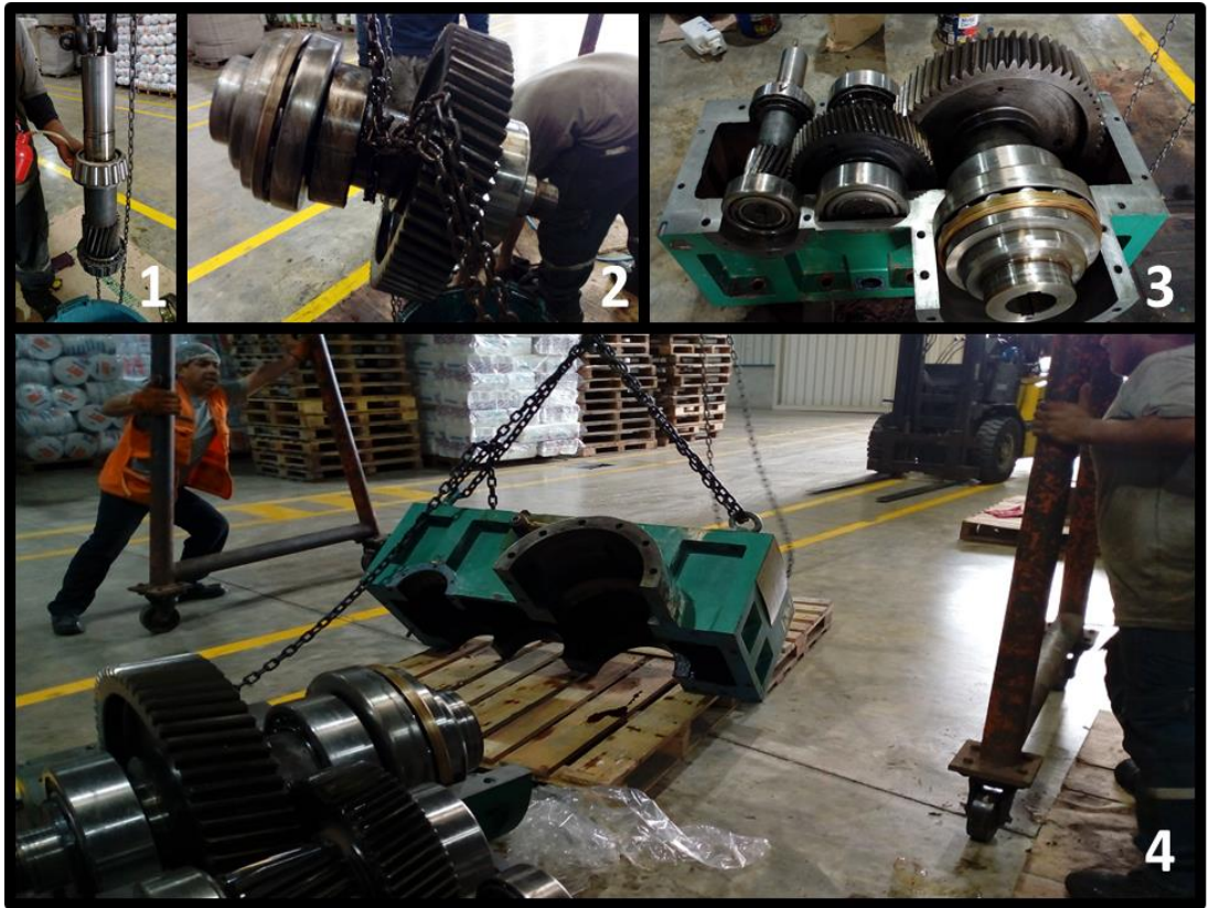
Figura 49. Mantenimiento a la Caja Reductora
