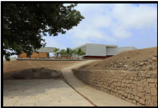
Ilustración 10: Fotografía. Vista Peatonal Recuperado de: https:// www.canaln.pe .
